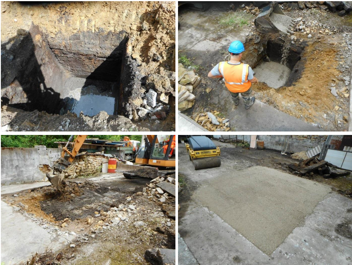
Photos B-11-14 : Travaux dans le puits des sondages n° 1 et n°2 Mise en sécurité définitive avec une obturation comprenant la mise en place d'une dalle en béton armée Photos extraite du Compte-rendu des travaux de juin 2018
