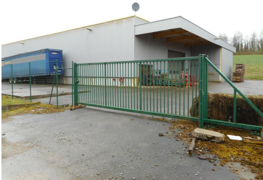
Figure B-18 : Le sondage n°11 se trouve derrière le portail, dans la parcelle n°62, section ZC, commune Gouhenans - Photo Avril 2018
