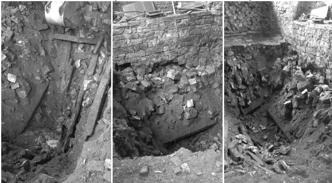
Figure 5: Travaux de recherche du puits en janvier 2018
