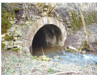
Point H (aval de la Saline)
