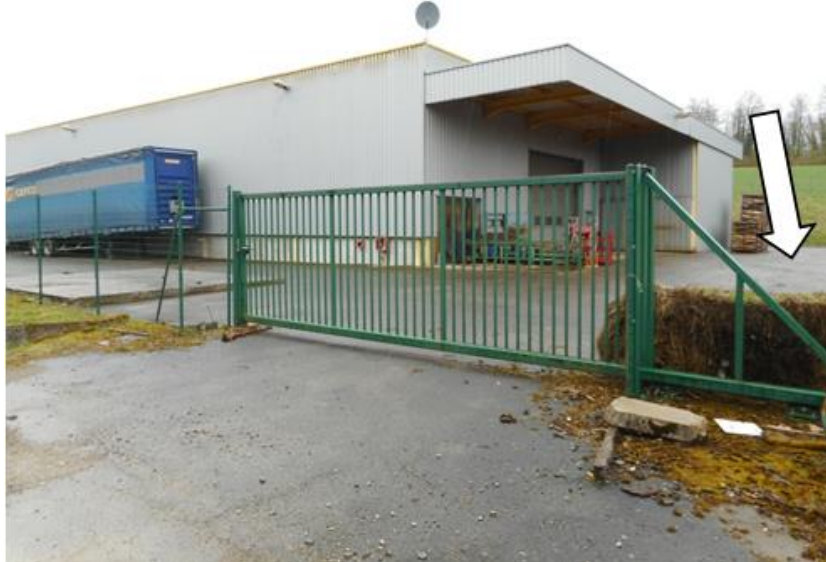
Photo K-12 : Emplacement du sondage n°11– Photo avril 2018
