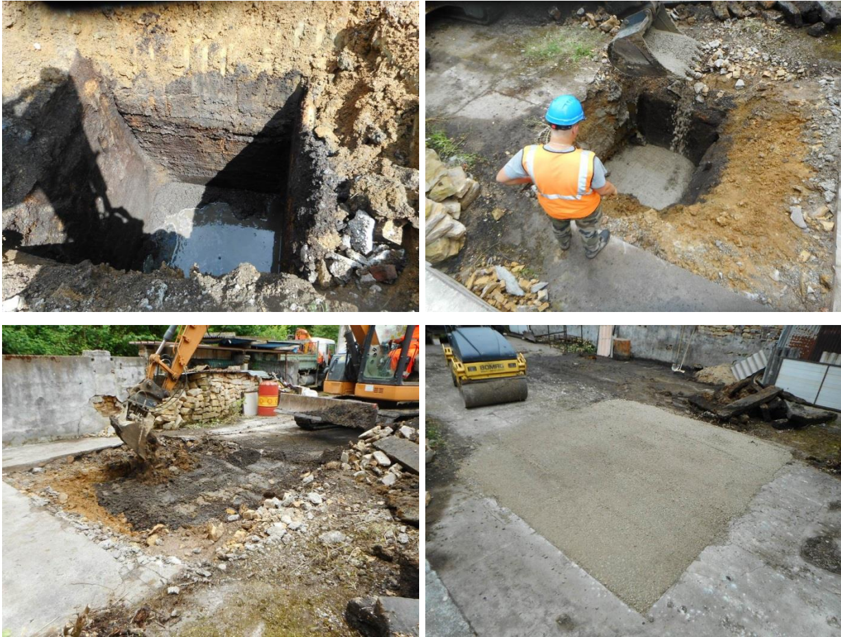
Photos K-1 à 4 : Travaux dans le puits des sondages n° 1 et n°2 et état actuel Mise en sécurité définitive avec une obturation comprenant la mise en place d'une dalle en béton armée Photos extraite du Compte-rendu des travaux de juin 2018
