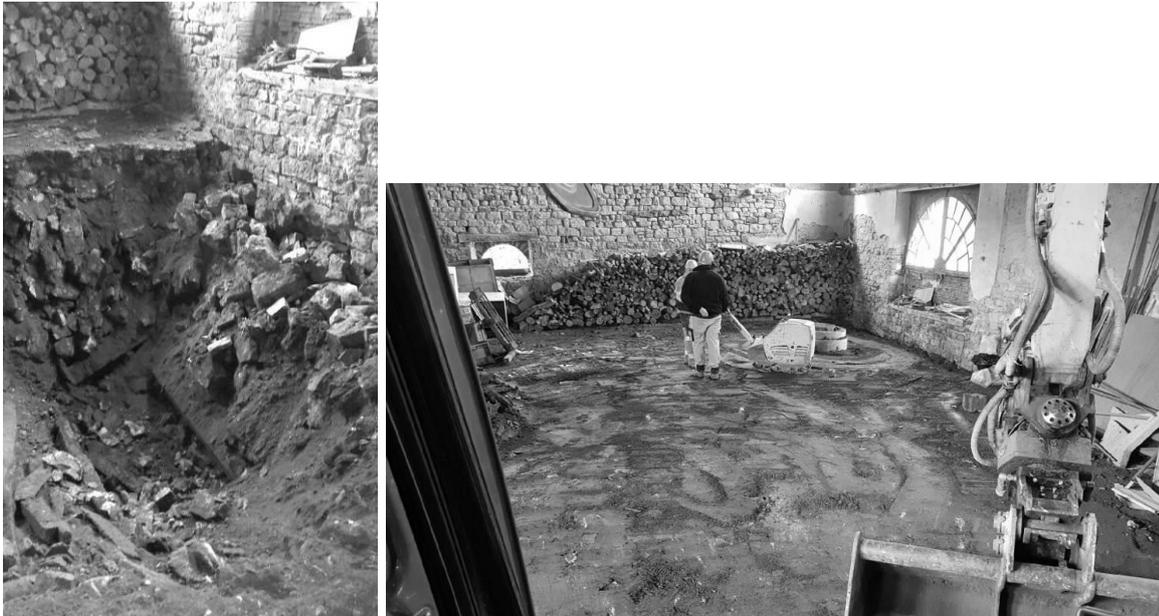
Figure 6: Travaux de recherche du puits et emplacement du puits (buse béton)
