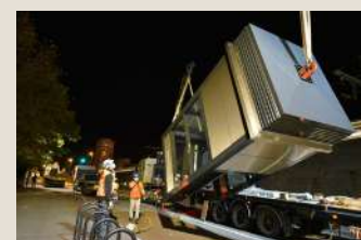
Préparation de la cage d'ascenseur avant son installation
