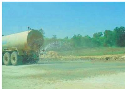
Figure 90 : Arrosage du chantier par temps sec (Source : SYSTRA)
