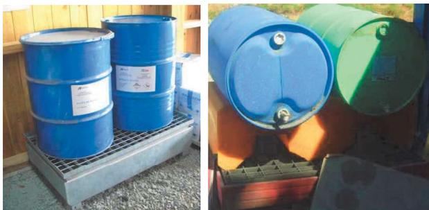
Figure 87 : Produits polluants stockés sur des bacs de rétention (Source : SYSTRA)
