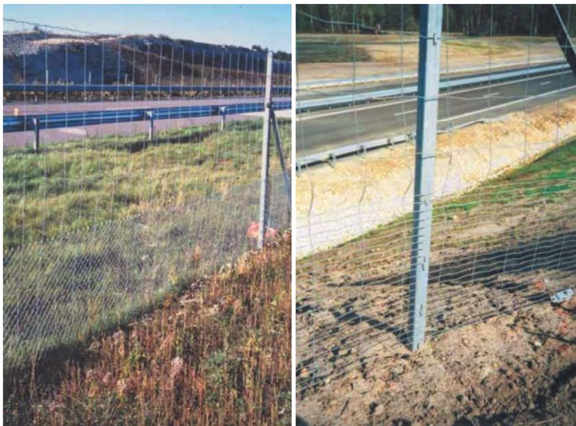
Figure 101 : Exemples d'une clôture autoroutière doublée d'un treillis à maille fine (Source : Sétra)
