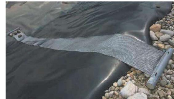
Figure 98 : Dispositifs permettant aux reptiles de s'échapper d'un bassin (source : SYSTRA)
