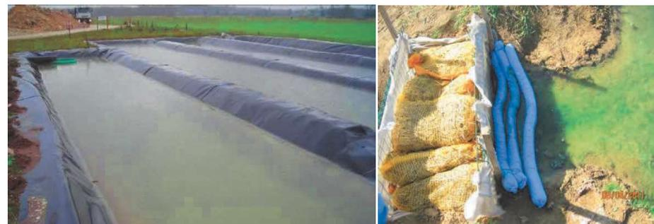
Figure 92 : Bassin de rétention provisoire bâché (Source : SYSTRA)
