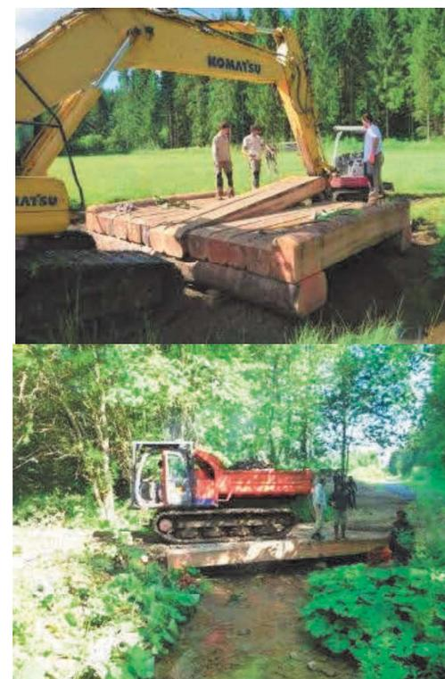
Figure 100 : Exemple de pont en bois permettant la traversée d'engin
