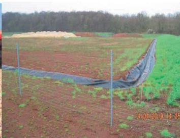
Figure 89 : Fossés autour des installations de chantier (Source : SYSTRA)
