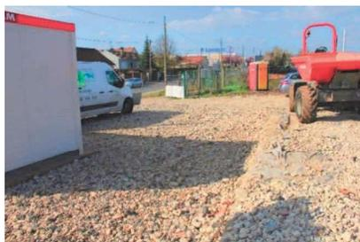
Figure 88 : Bâches et pierres concassées au niveau des installations de chantier (Source : SYSTRA)
