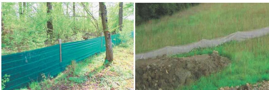
Figure 96 : Barrières à batraciens en phase chantier (Source : SYSTRA)
