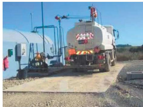
Figure 85 : Exemple de zone étanche pour le ravitaillement des véhicules en carburant (Source : SYSTRA)
