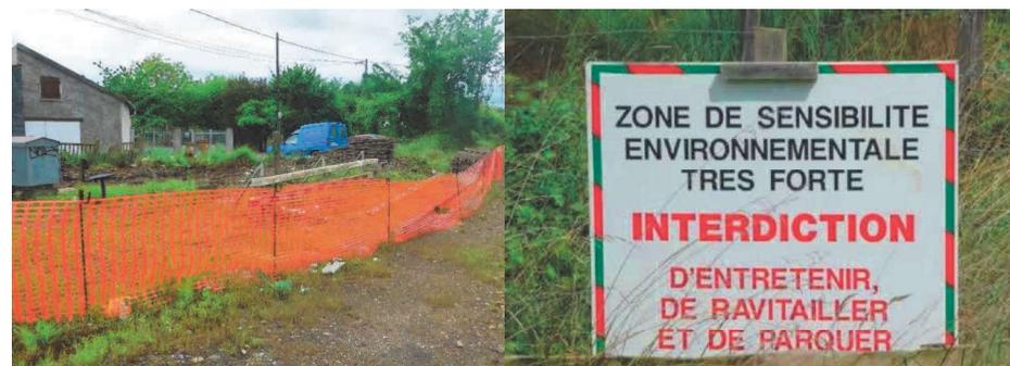
Figure 95 : Exemples de barrières de chantier et de panneaux indicatifs (Source : SYSTRA)
