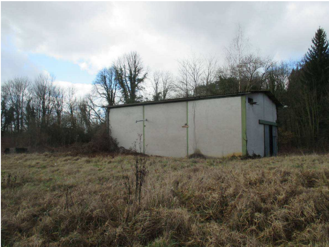
Bâtiment à l'Ouest de l'usine
