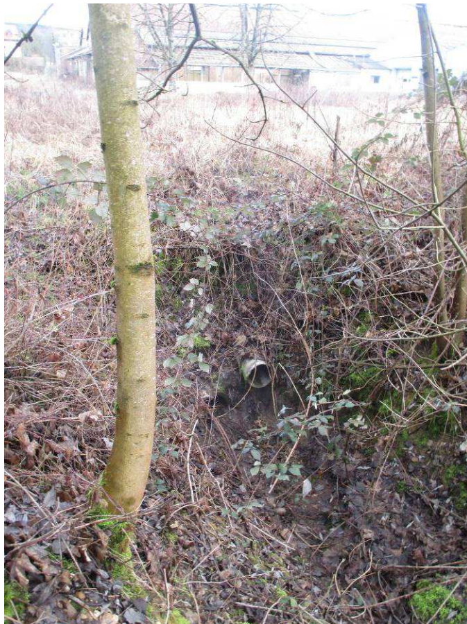
Fossé au Sud avec 2 arrivées d'eau
