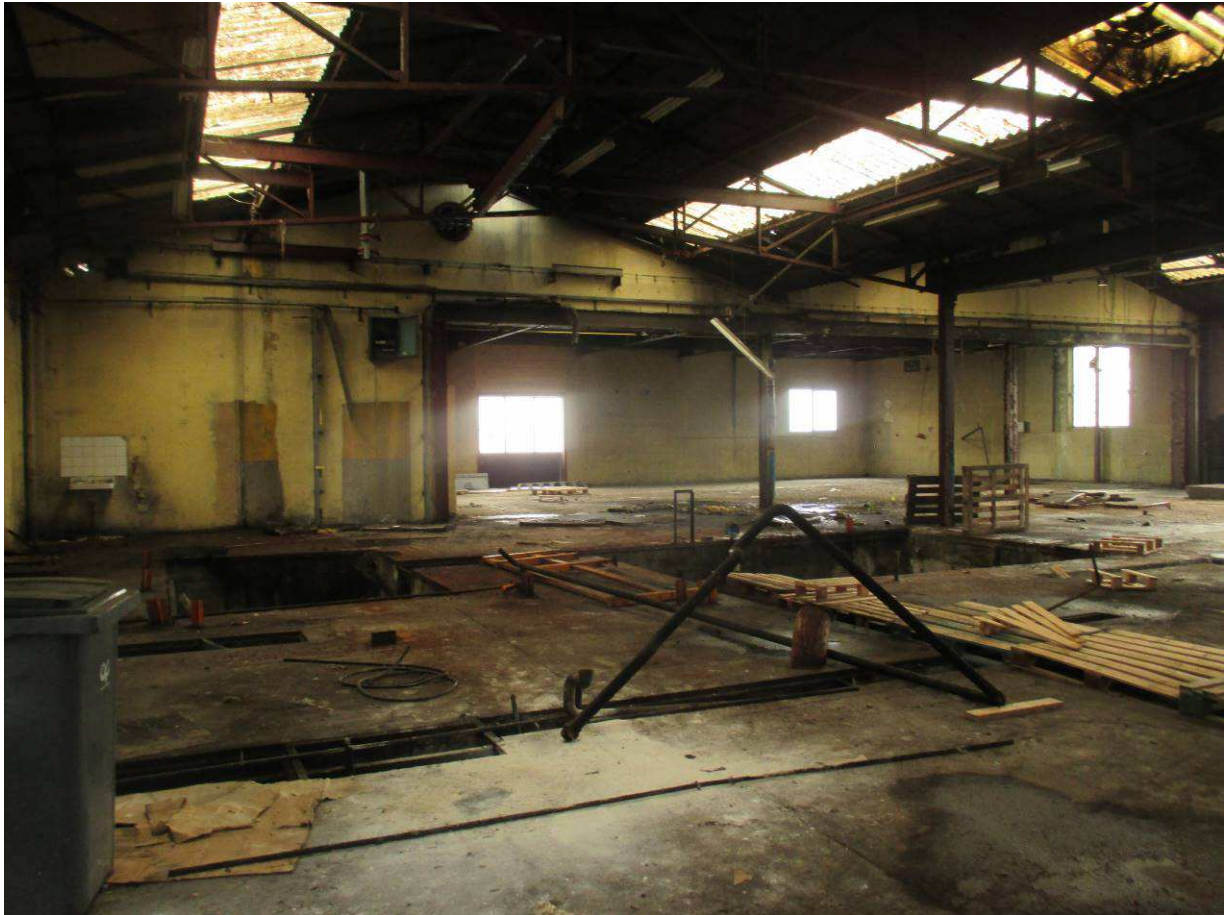
Atelier au Sud de l'usine
