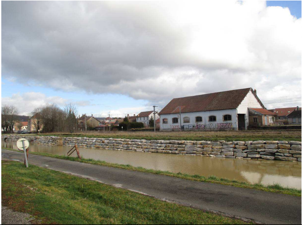
Canal Rhin/Rhône à l'Est du site
