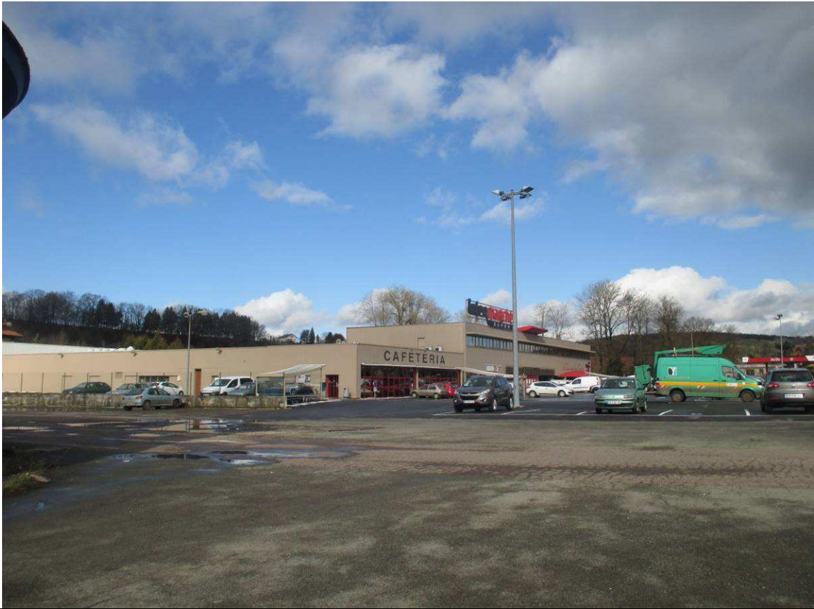
Vue de l'Intermarché depuis l'entrée de l'usine
