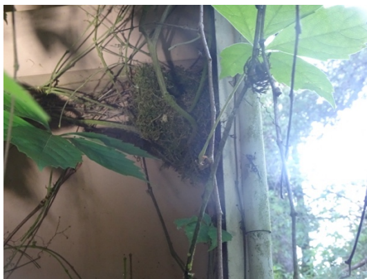
Figure 12 : Ancien nid de Troglodyte mignon observé en façade nord du logement du gardien
