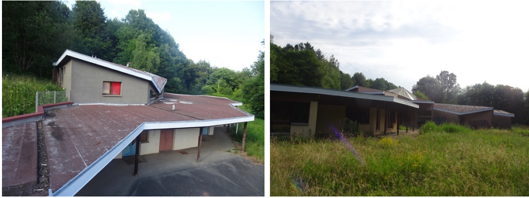
Figure 2 : Bâtiment soumis à expertise les 04/05, 20 et 21/06/22
