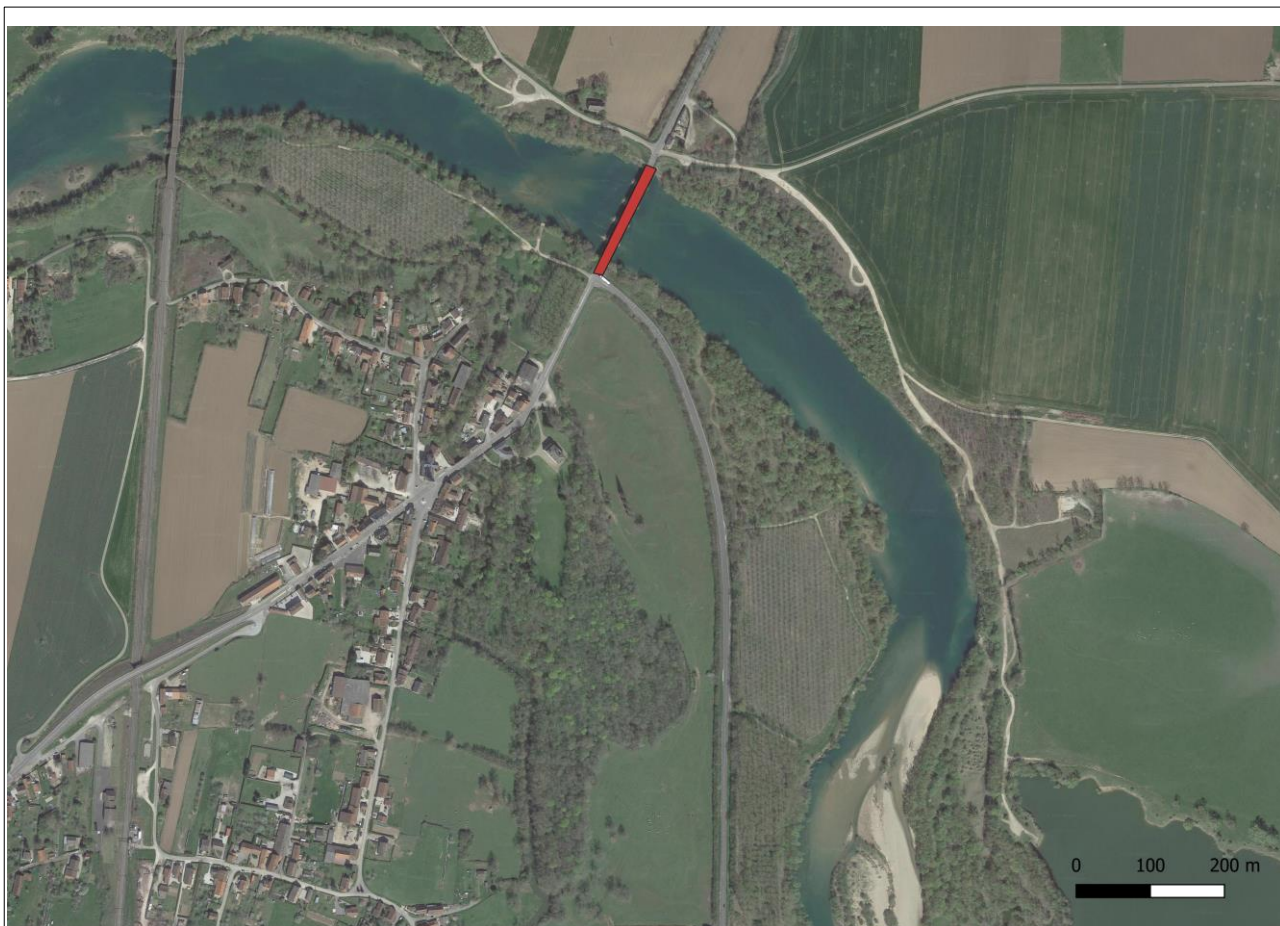
Carte 1 : Localisation du Pont de Navilly (surligné en rouge)
