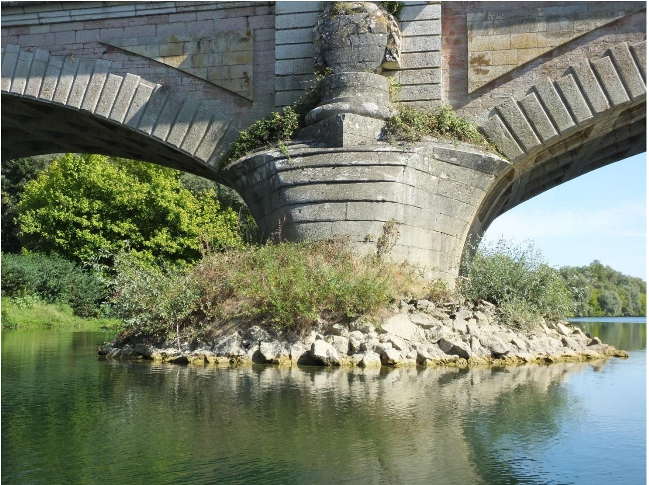
Figure 14: Enrochement favorable à la Couleuvre vipérine
