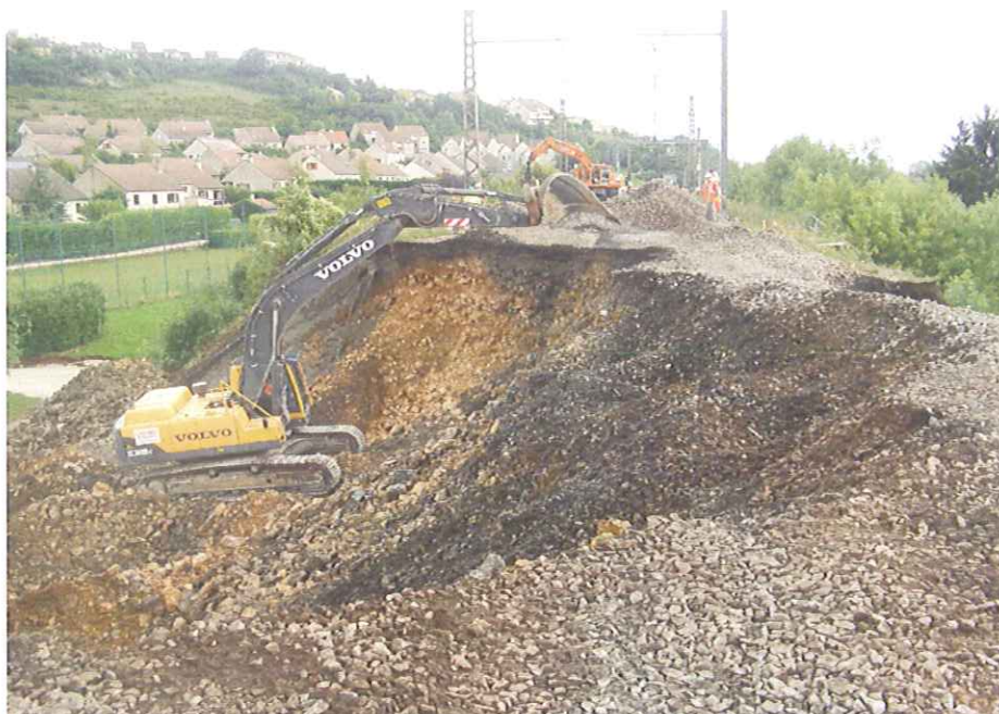
Terrassements du 23 août 2010 à 12 h
