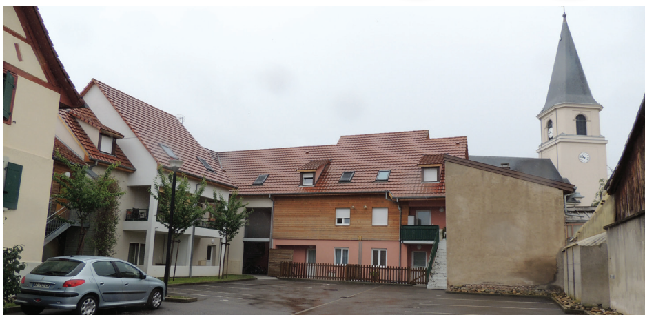
La « Cour Zurbach » à Reiningue. Le logement social permet de réhabiliter l'existant en créant du logement destiné aux revenus modestes.
