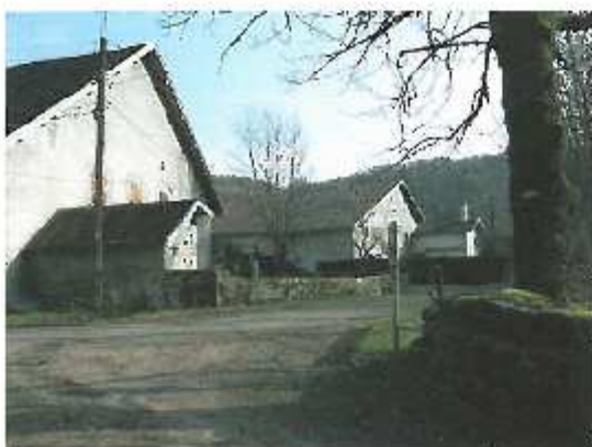
Les éléments structurant et valorisant l'espace public doivent être préservés et souvent réhabilités.
