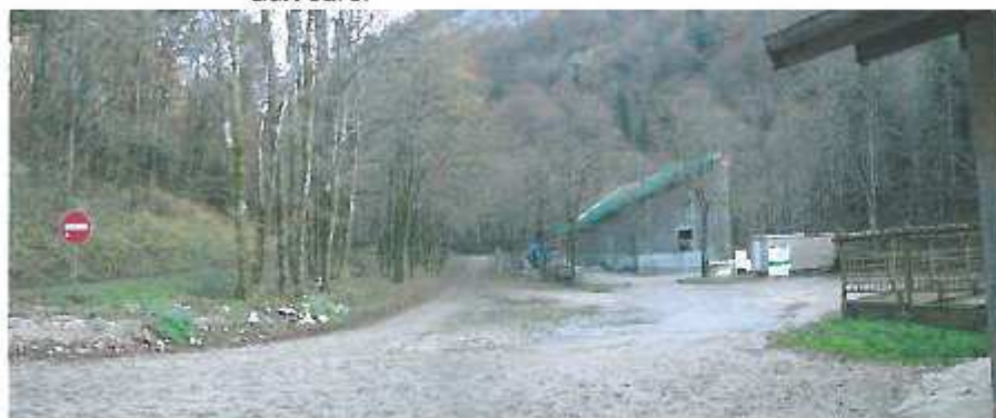
La maison des Cascades - état des travaux Novembre 2002
