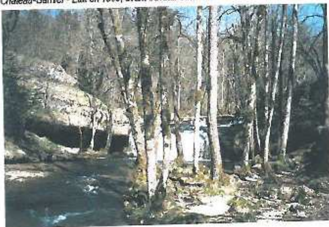
Château-Garnier - Etat en 1999, avant travaux d'intervention.
