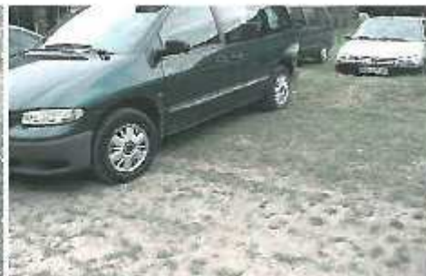
Difficulté de reprise du gazon sur structure alvéolaire dans les conditions de mise en œuvre et d'entretien précitées.
