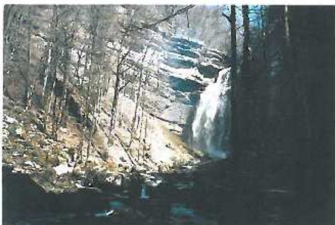
Le Grand-Saut - Etat avant intervention (1999).
