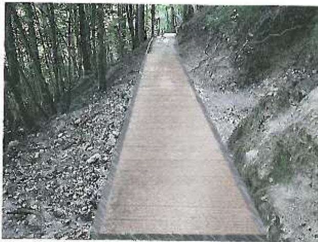
reprise du fil d'eau par une rigole maçonnée
