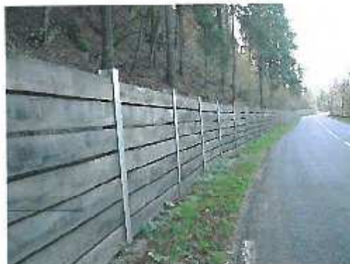
Image de référence : stabilisation de talus.
