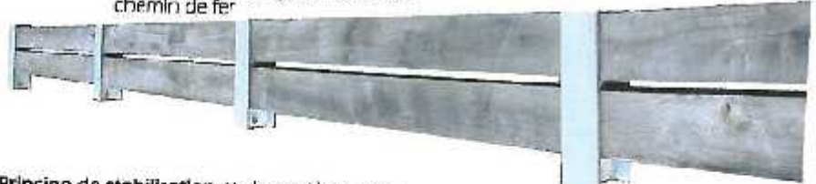
fer profil IPN, dans massif de fondation enterré
