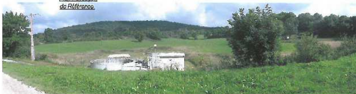
Station d'épuration du Frasnois. Etat actuel.
