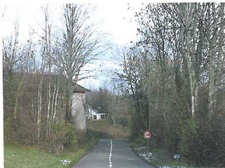
Effet de porte grâce au bâti ancien.
