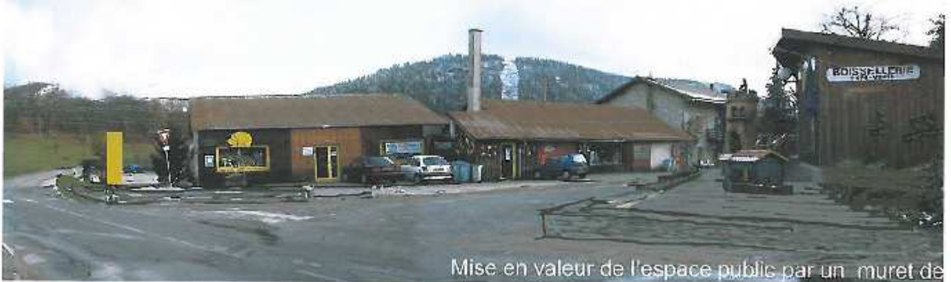
Les plantations, l'unification des toitures, les murets apportent davantage d'homogénéité à l'ensemble et affirment la qualité d'espace public. Une simplification des façades des commerces doit encore être recherchée.
