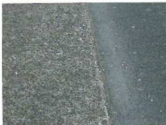
Principe de liaison béton désactivé enrobé.
