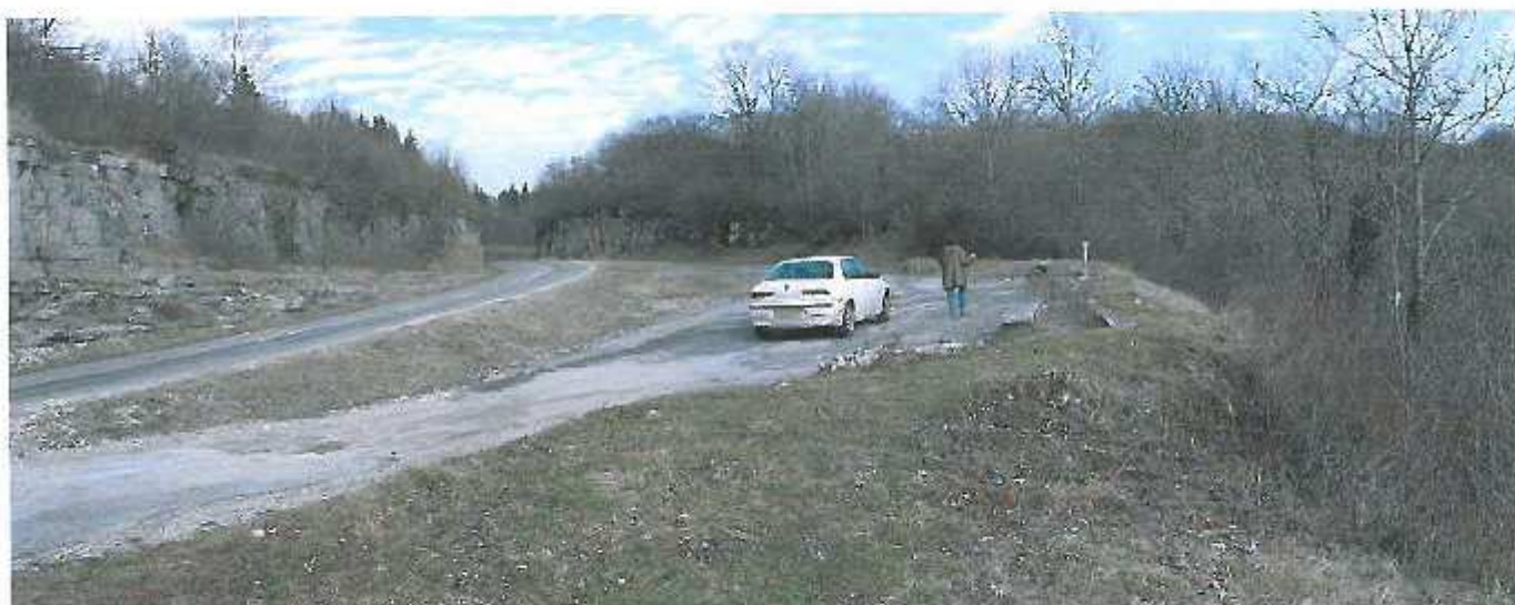
Éclvédère de la Chambre du prince : état actuel. (Février 2001)
