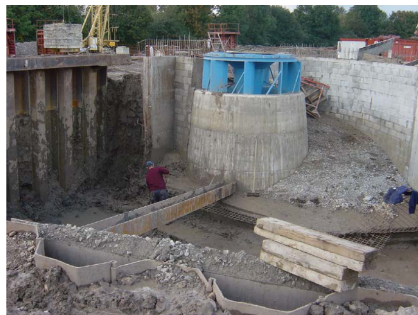
Construction d'un nouveau groupe hydroélectrique
