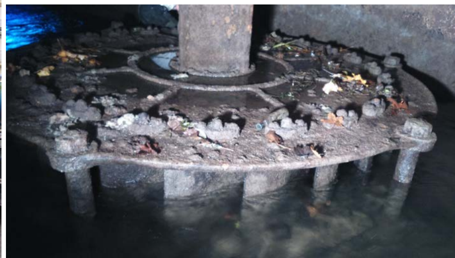
Inspection d'une turbine Francis
