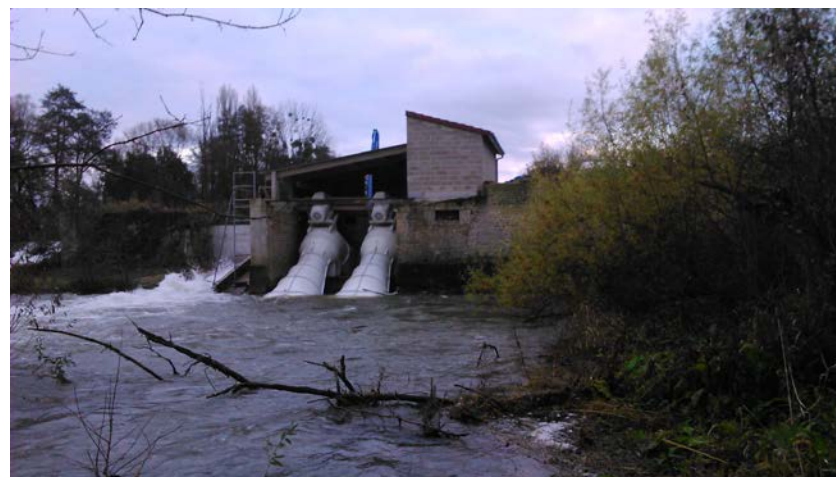
Construction d'une passe à poisson et vue aval de deux groupes kaplan avec leur rampe de dévalaison
