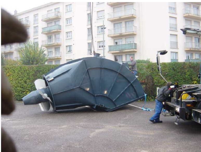
Mise en place d'un nouveau groupe kaplan sur la Saône
