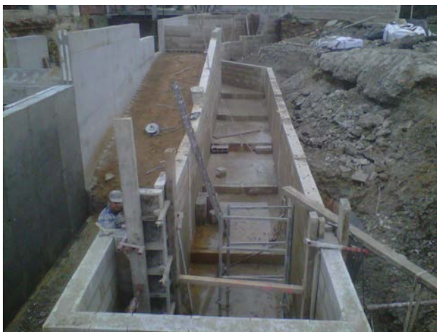
Construction d'une passe à poisson et vue aval de deux groupes kaplan avec leur rampe de dévalaison
