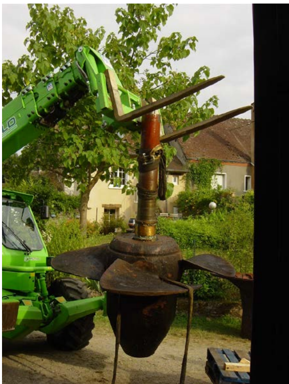
Démontage pour révision d'une turbine Kaplan
