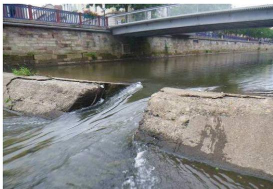
Photographie de l'échancrure dans l'ouvrage
