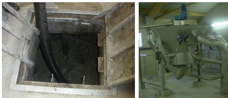
Photographies du dégraisseur-dessableur de la STEP
