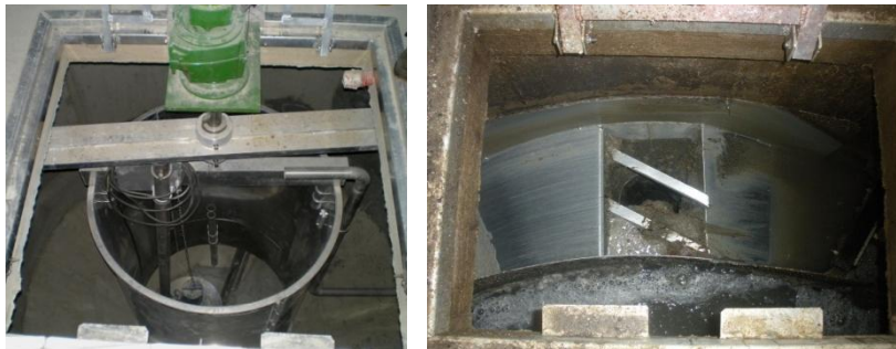
Photographies du dégraisseur-dessableur de la STEP
