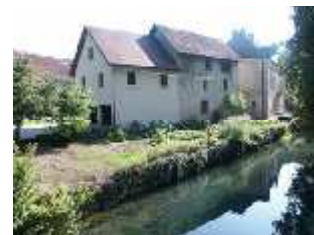
Cours d'eau de la Cuisance empierré.
