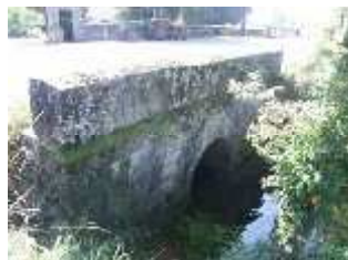
Ponceau de pierre face à la ferme.
