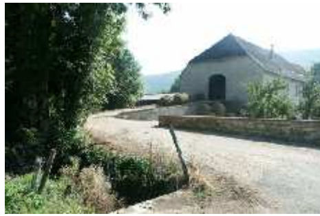
Corps de ferme massif, d'orientation nord-ouest / sud-est comme les autres bâtiments anciens, dont l'ancien enduit a été enlevé au profit de la pierre apparente jointoyée.
