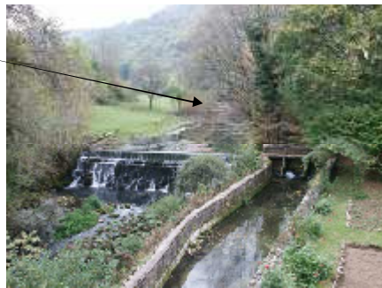
Enrochement lié à l'ouvrage hydraulique éboulé
