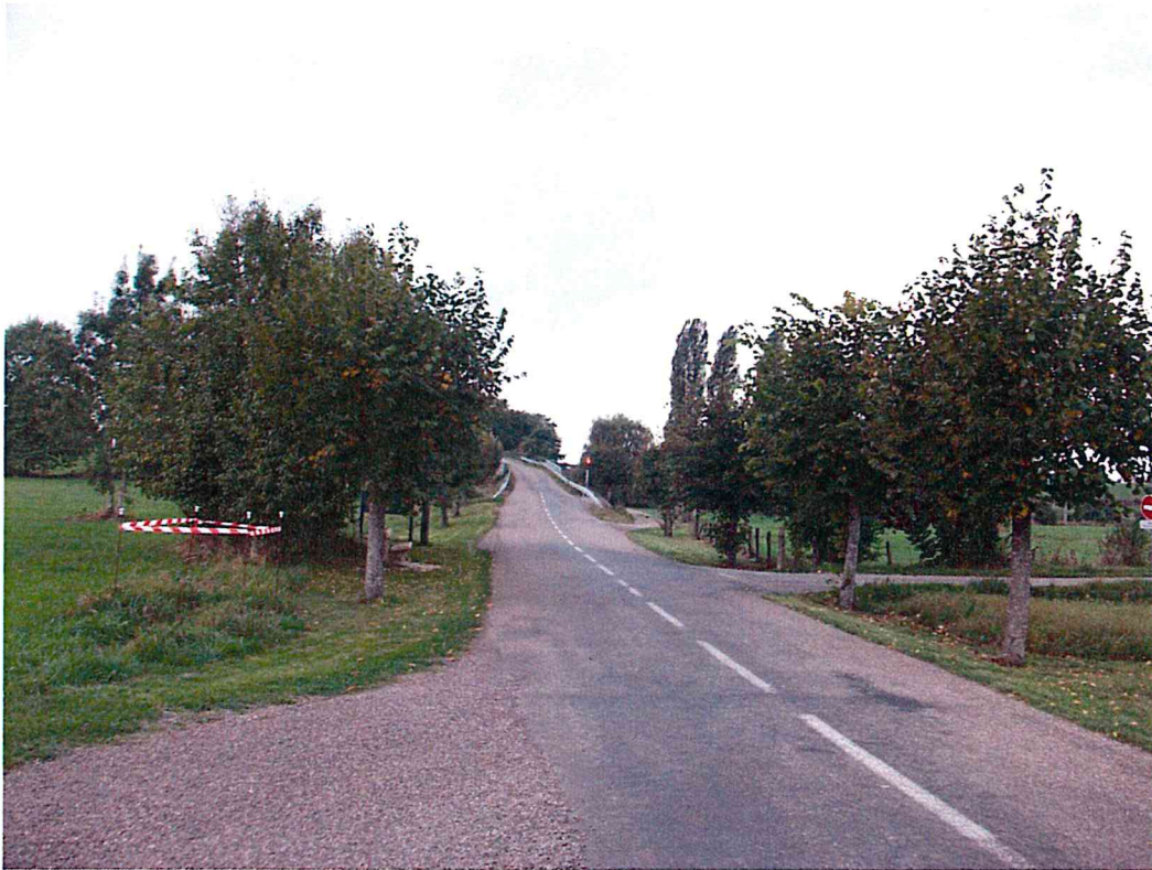
Photo 37 : Chemin d'exploitation dit de « Saint Pierre, arrivée sur la RD 249 (commune de Baulay ) traversée de la Saône sur l'ouvrage d'art de la RD 249
