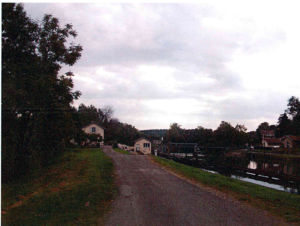
Photo 22 : Fin de la section 11 (5650 mètres), vue sur chemin de halage au niveau l'écluse de Conflandey (Commune de Conflandey)
