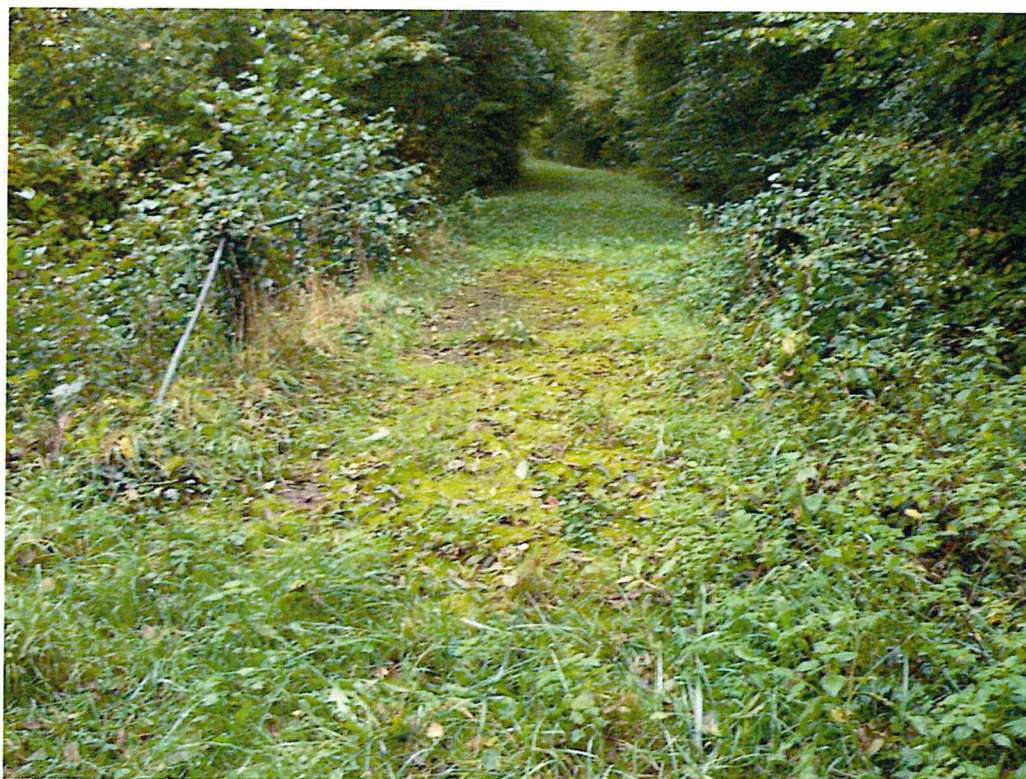
Photo 73 : Chemin de halage au PK 405 sur l'ouvrage de franchissement du ruisseau du « Bas d'Anivau »( commune d'Ormoy )
