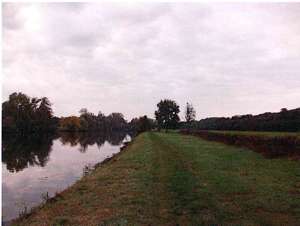
Photo 19 : Vue sur le chemin de halage après le PK 371 le chemin est bordé par une prairie avec une haie (commune de Chaux-les-Port)
