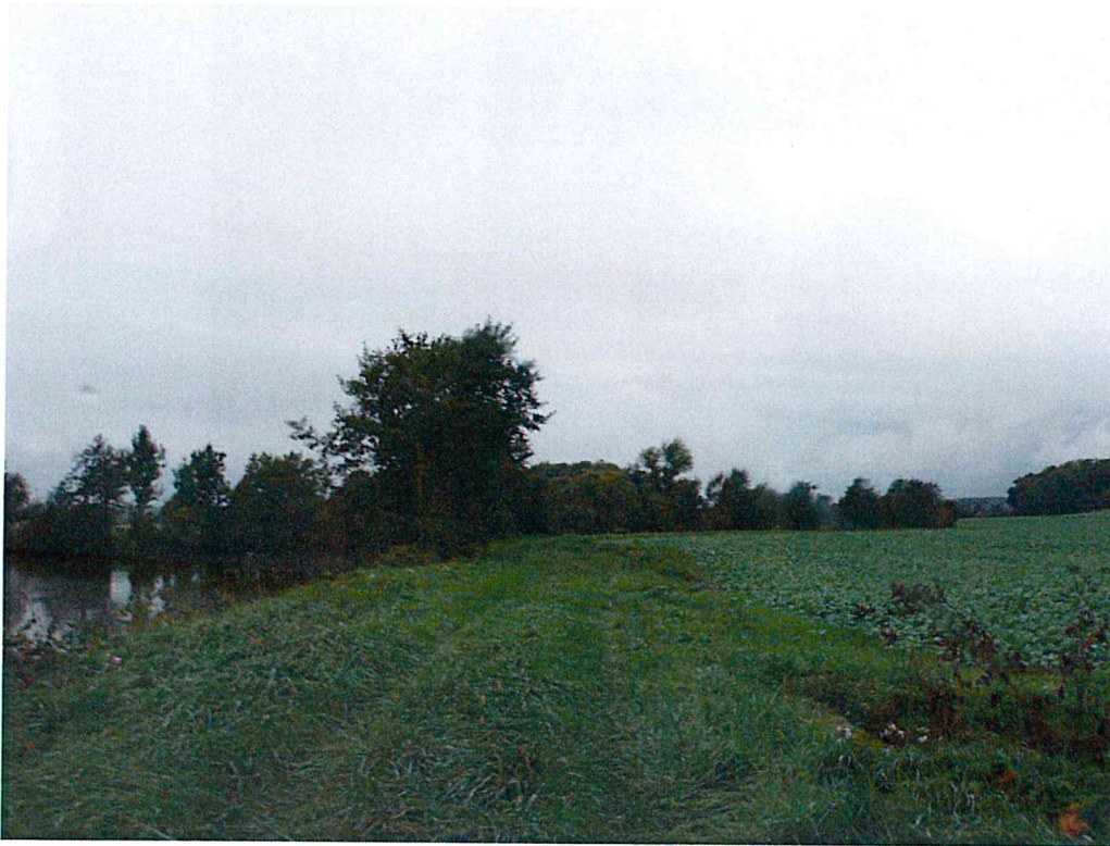
Photo 49 : Chemin de halage enherbe PK 389 lieu-dit « les Lochères » (commune de Cendrecourt)
