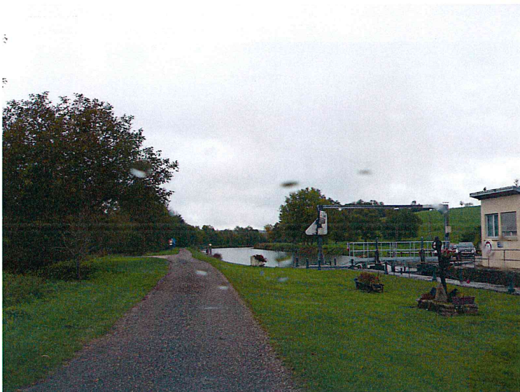
Photo 56 : Chemin de halage, au début de la section 5/fin de la section 4, écluse de Cendrecourt (commune de Cendrecourt)
