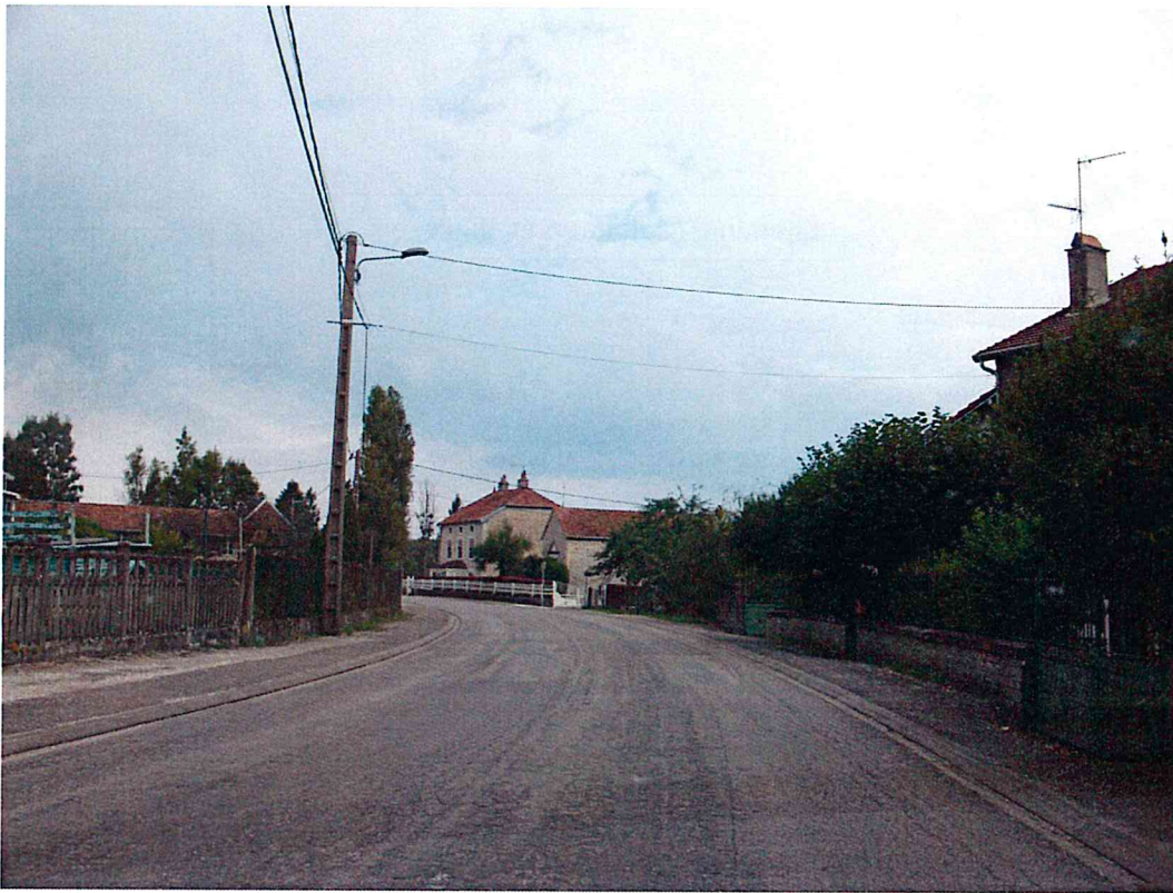
Photo 29 : RD 7, traversée de Port d'Atelier Village (commune de Purgerot)
