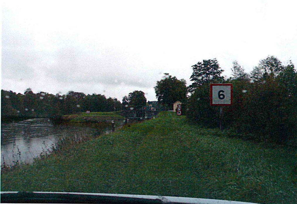
Photo 66 : Chemin de halage au PK 401 à l'écluse d'Ormoy (commune d'Ormoy)
