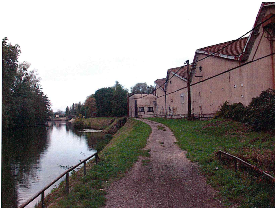
Photo 21 : vue sur chemin de halage au niveau de l'usine de Conflandey avec passerelle à rénover (commune de Conflandey)
