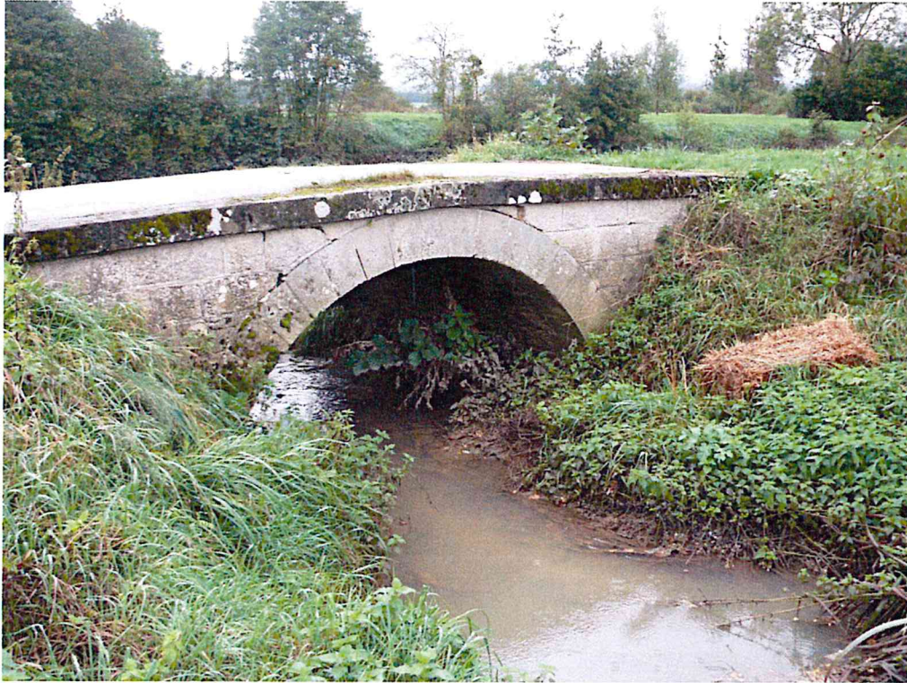
Photo 53 : Chemin de halage au passage sur l'ouvrage de franchissement du ruisseau de Tercey (commune de Cendrecourt)
