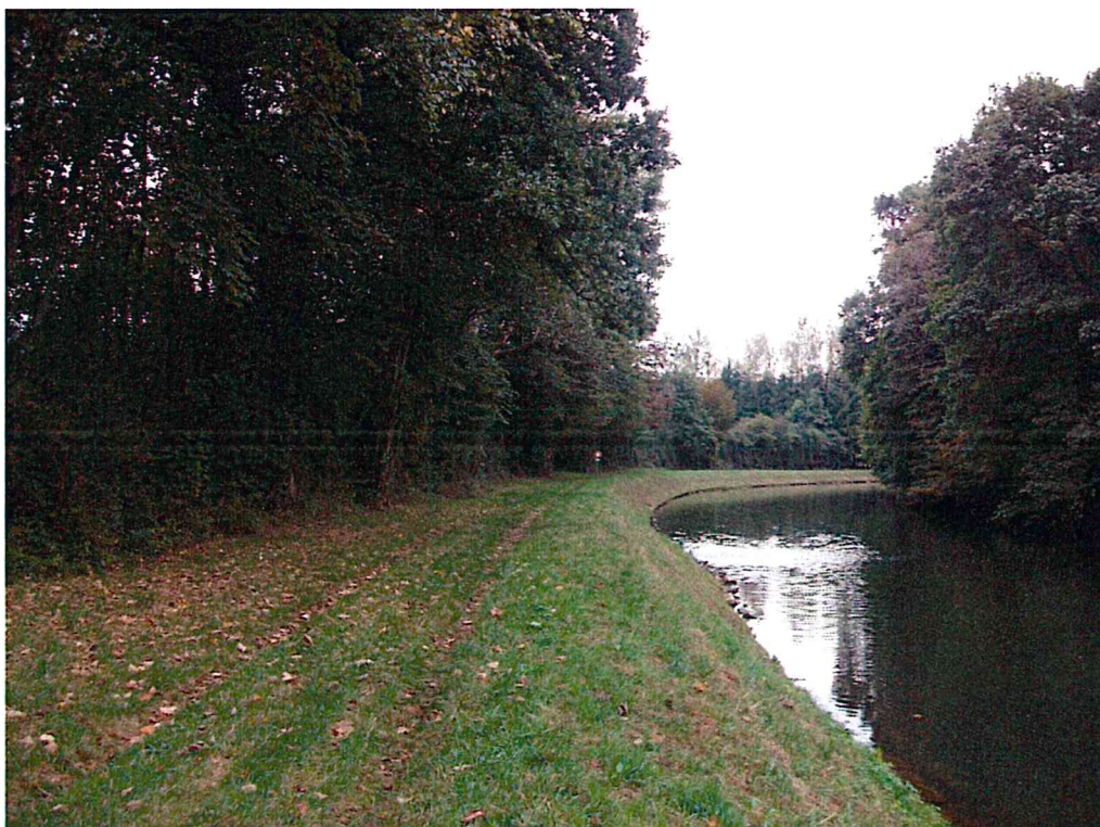
Photo 20 : Vue sur chemin de halage avant l'arrivée à Conflandey une haie d'arbres de hautes tiges délimite le chemin (commune de Conflandey)
