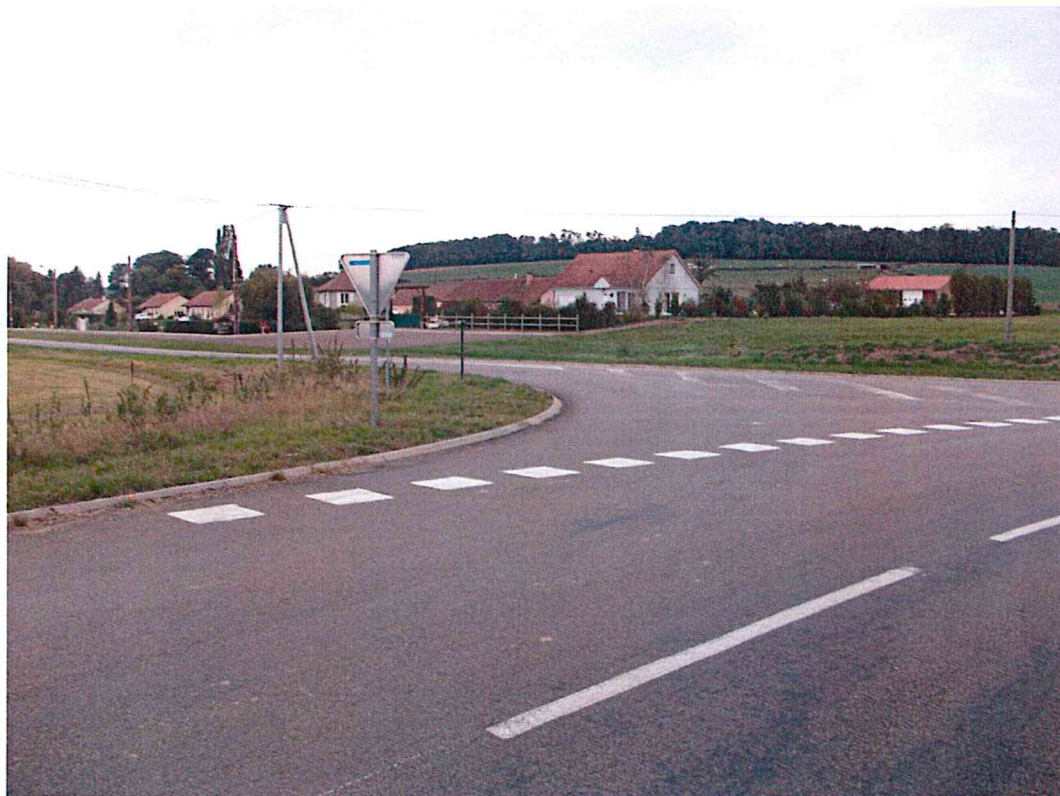
Photo 42 : Carrefour RD 54 et RD 296 (commune de Montureux-les-Baulay )
