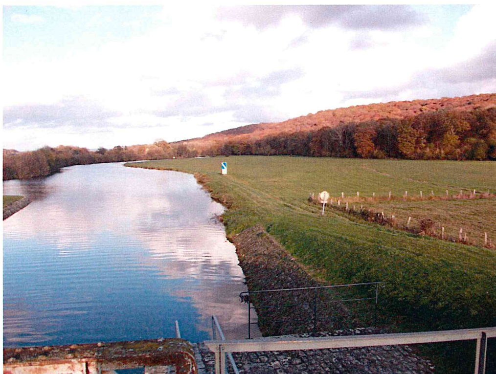
Photo 60 : Chemin de halage au nord de la passerelle du barrage de Cendrecourt (commune de Cendrecourt)
