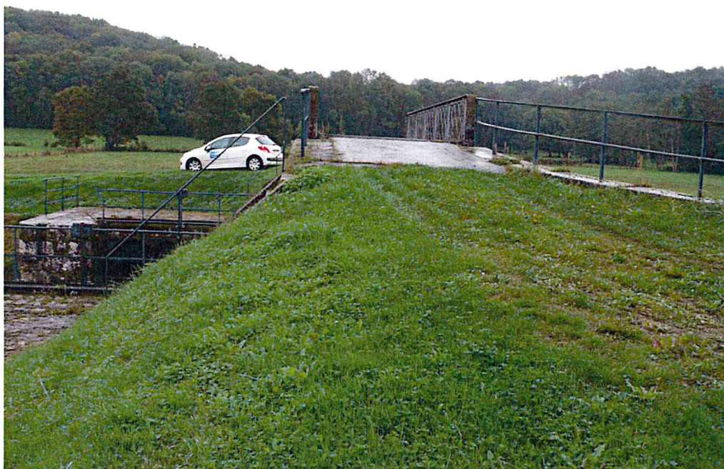
Photo 59 : Passerelle du barrage de Cendrecourt à la fin de la section 3/début de la section 4 (commune de Cendrecourt)
