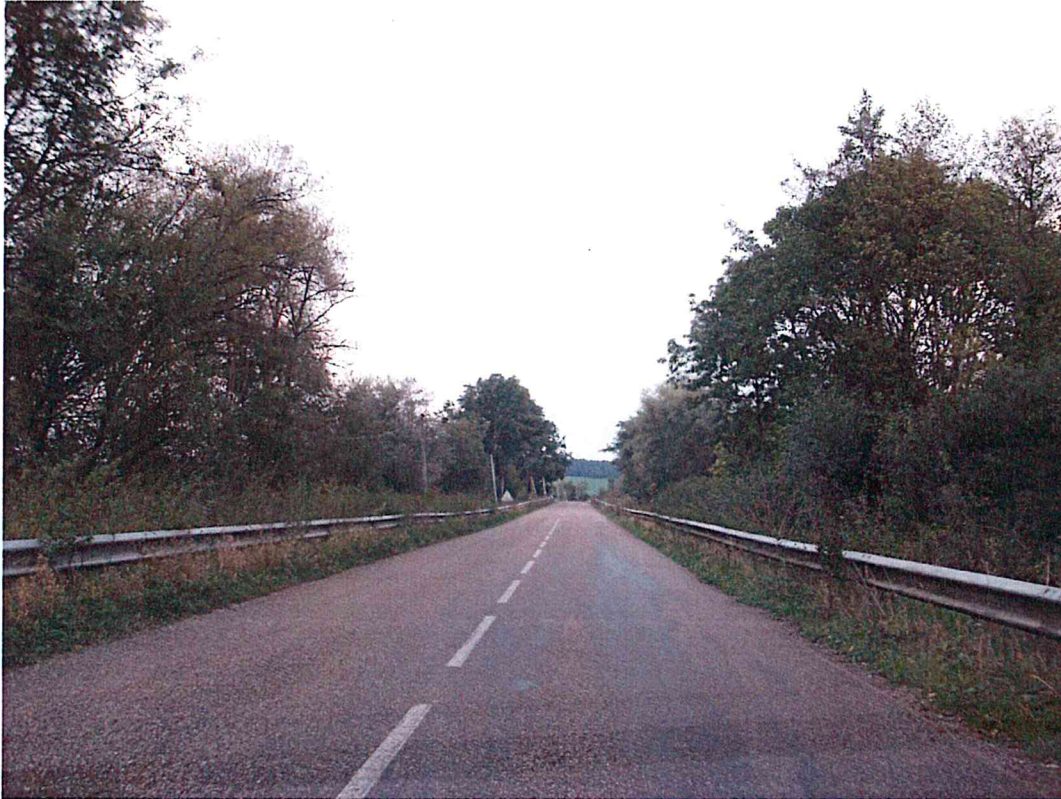
Photo 41 : RD 54, au lieu-dit « la Hatre » (commune de Gevigney et Mercey)
