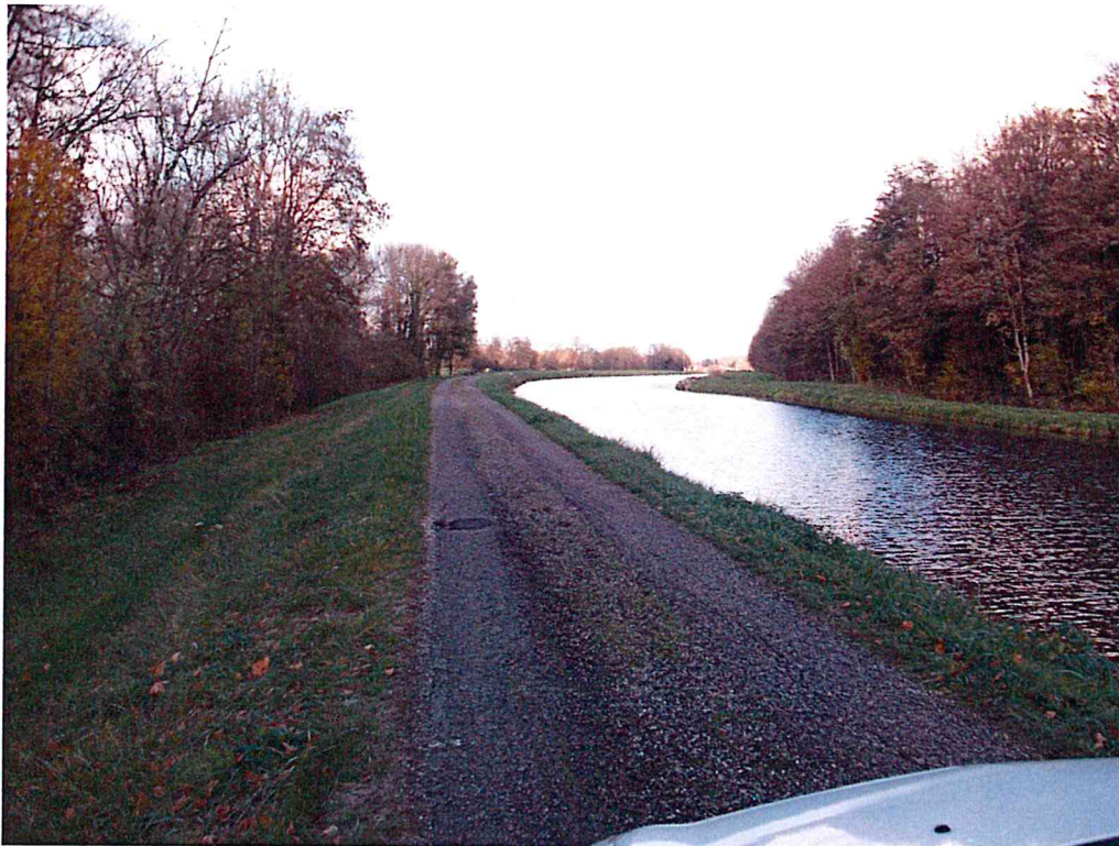
Photo 57 : Chemin de halage au PK 393 à Cendrecourt (commune de Cendrecourt)
