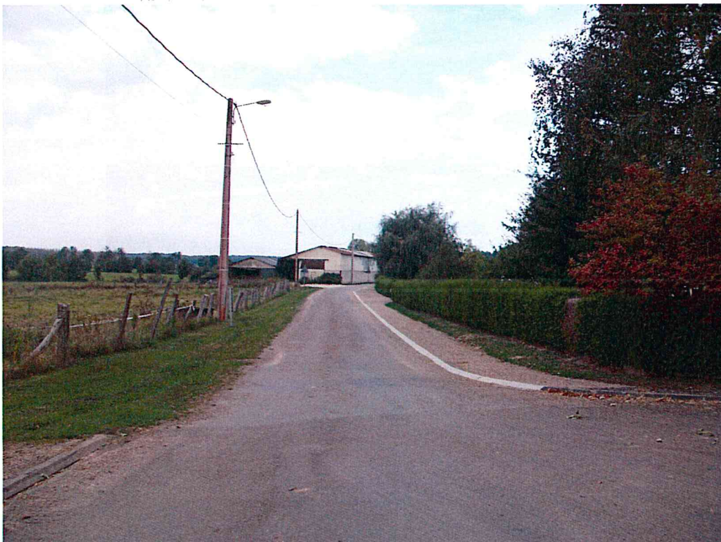
Photo 44 : Carrefour Grande rue/ rue du Pont Noir (commune de Montureux-les-Baulay )
