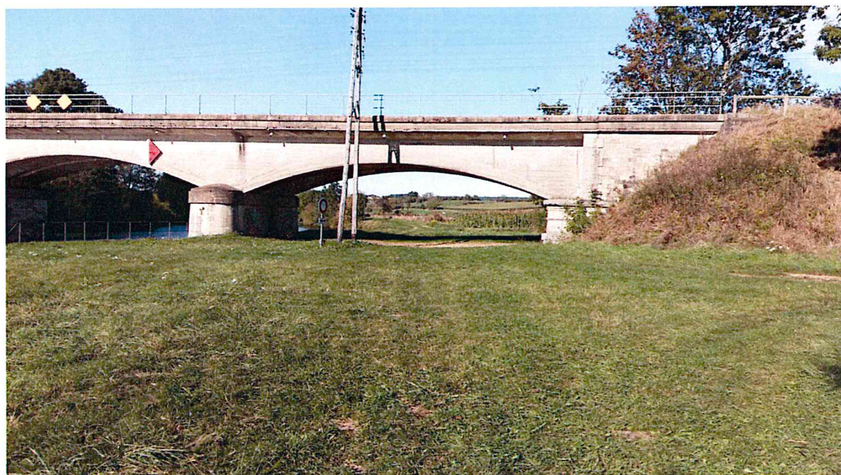
Photo 52 : Chemin de halage au niveau du pont du chemin de fer (commune de Cendrecourt)
