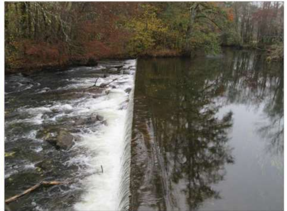
Photo 5 Vue de la crête du barrage et de l'échancrure centrale
