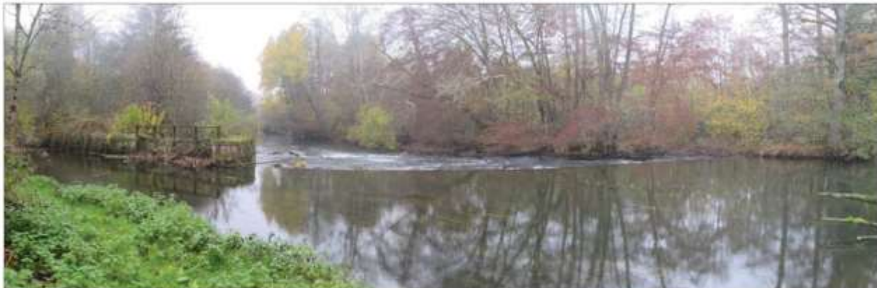
Photo 1 Vue amont du barrage
