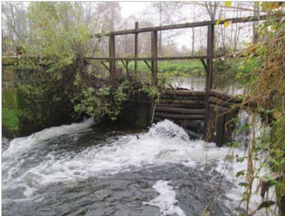
Photo 4 Vue aval du vannage de décharge
