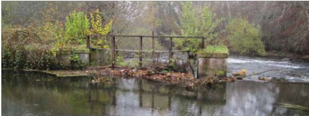
Photo 3 Vue amont du vannage de décharge
