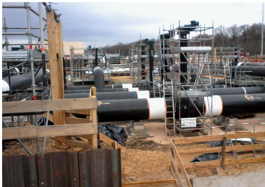
Travaux préparatoires au raccordement de l'artère Val de Saône à Palleau (71) – février 2017
