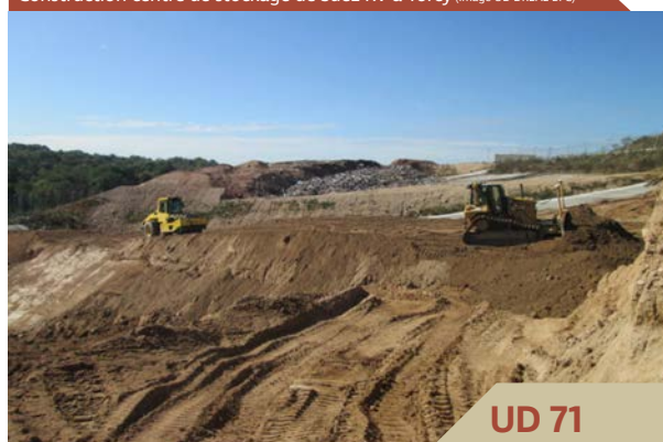
Construction centre de stockage de Suez RV à Torcy (image UD DREAL BFC)
