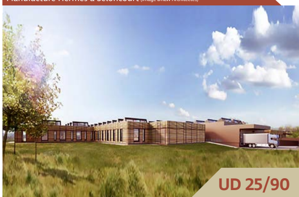
Manufacture Hermès à Seloncourt (image DRLW Architectes)
