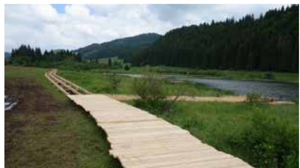
réalisation d'un platelage à Lamoura (39) (crédit photo : P. Durllet - PNR HJ)
