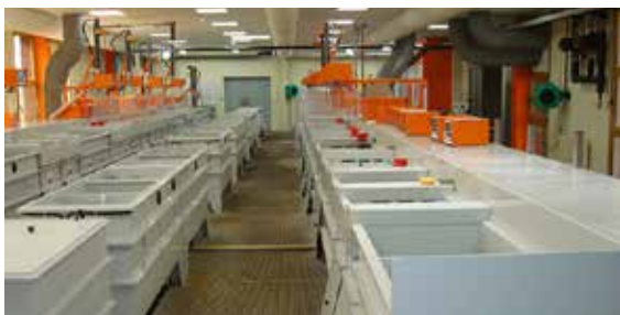
Sté SILVANT - installation de traitement de surfaces - crédit photo : Sté SILVANT
