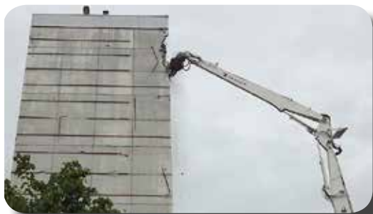
technique de démolition dite «du grignotage» (crédit photo DREAL FC)
