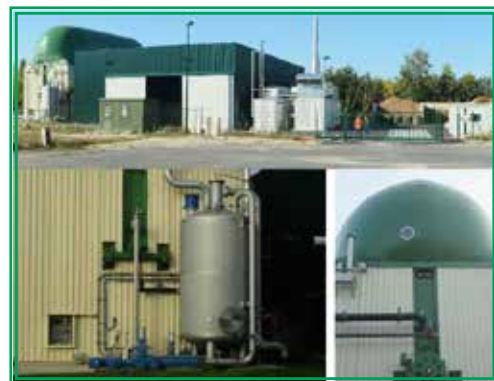
site de la Ferté Saint Aubin (45), (technologie Ogin) similaire à ce que sera Dole crédit photo : Naskeo environnement
