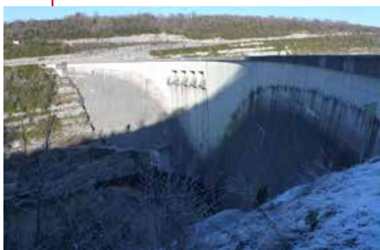
barrage de Vouglans dans le Jura crédit photo Dreal FC
