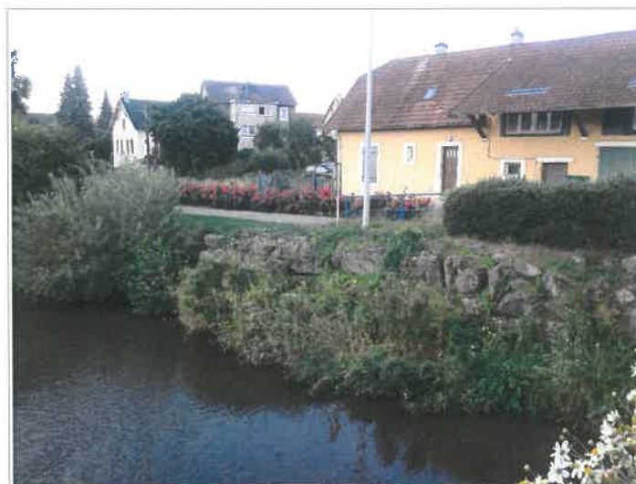
Vue des enrochements à l'aval du pont Blumberg
