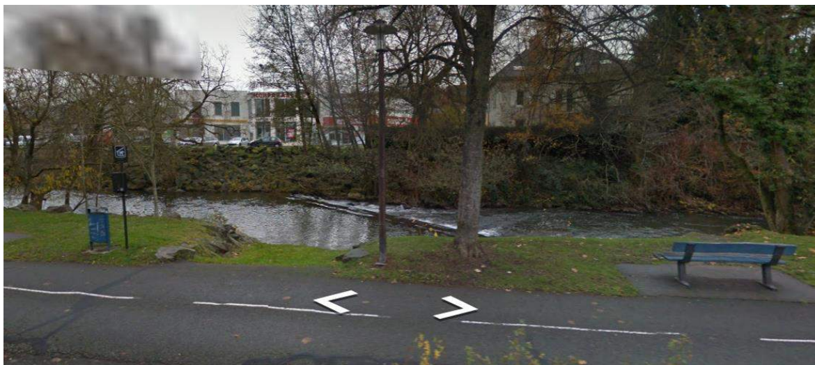
Fig. 33. Accès en rive droite au droit de l'ouvrage ROE55862 en aval du pont Blumberg
