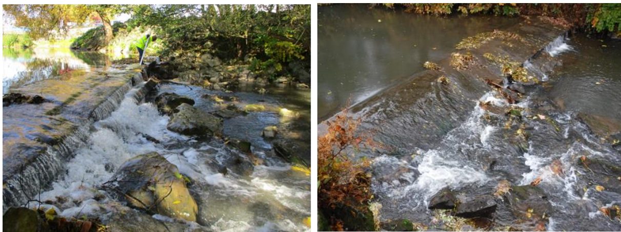
Fig. 25. Discontinuités de fond observées à l'aval des ouvrages étudiés
