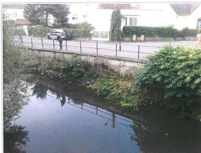
Vue du mur le long de la rue du 11 novembre
