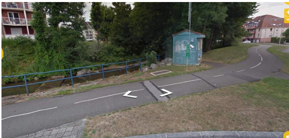
Fig. 35. Accès en rive droite au droit de l'ouvrage ROE55861
