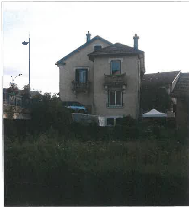
Vue du bâtiment à proximité du pont Carnot
