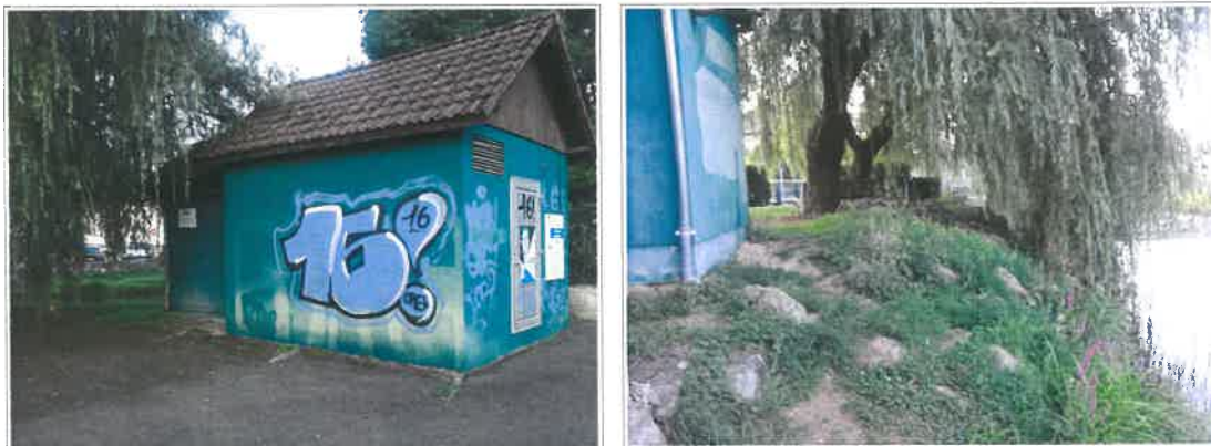
Vue du Poste Enedis
