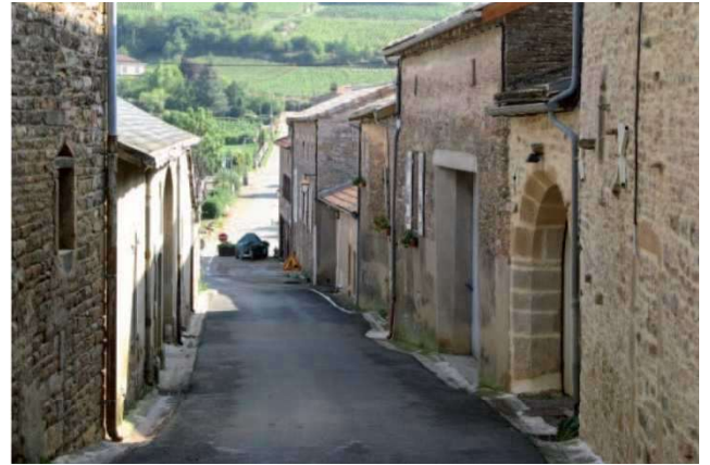
Les constructions sont alignées sur rue avec une façade sur rue très fermée
