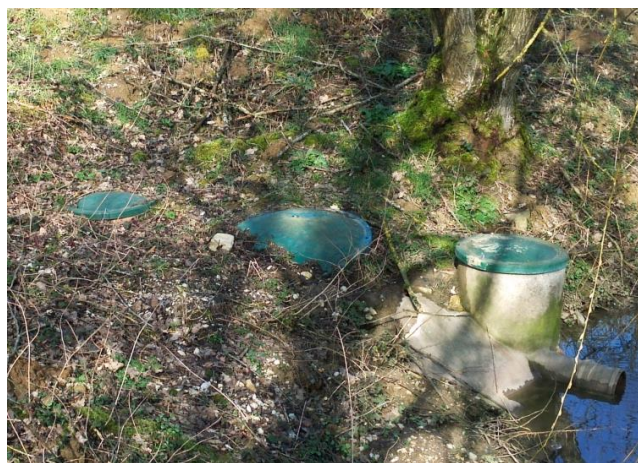
Photographie des regards d'accès au décanteur-digester
