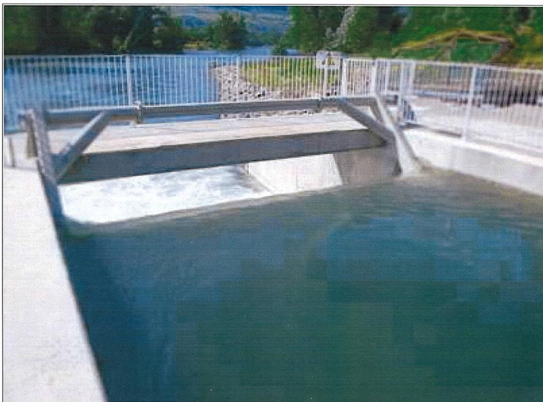
*VLH submergée en position de fonctionnement*
