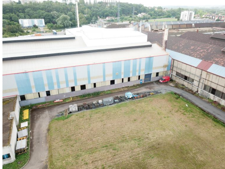
PC7 Façade aérienne nord
