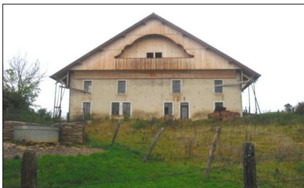
L'ossature de la ferme jurasienne est constituée par la charpente à colonnes. Les pièces qui la constituent viennent prendre appui au sol sur des pierres (levures) ou sur des semelles de bois. Elles soutiennent l'ensemble de la couverture et une partie des planchers.
