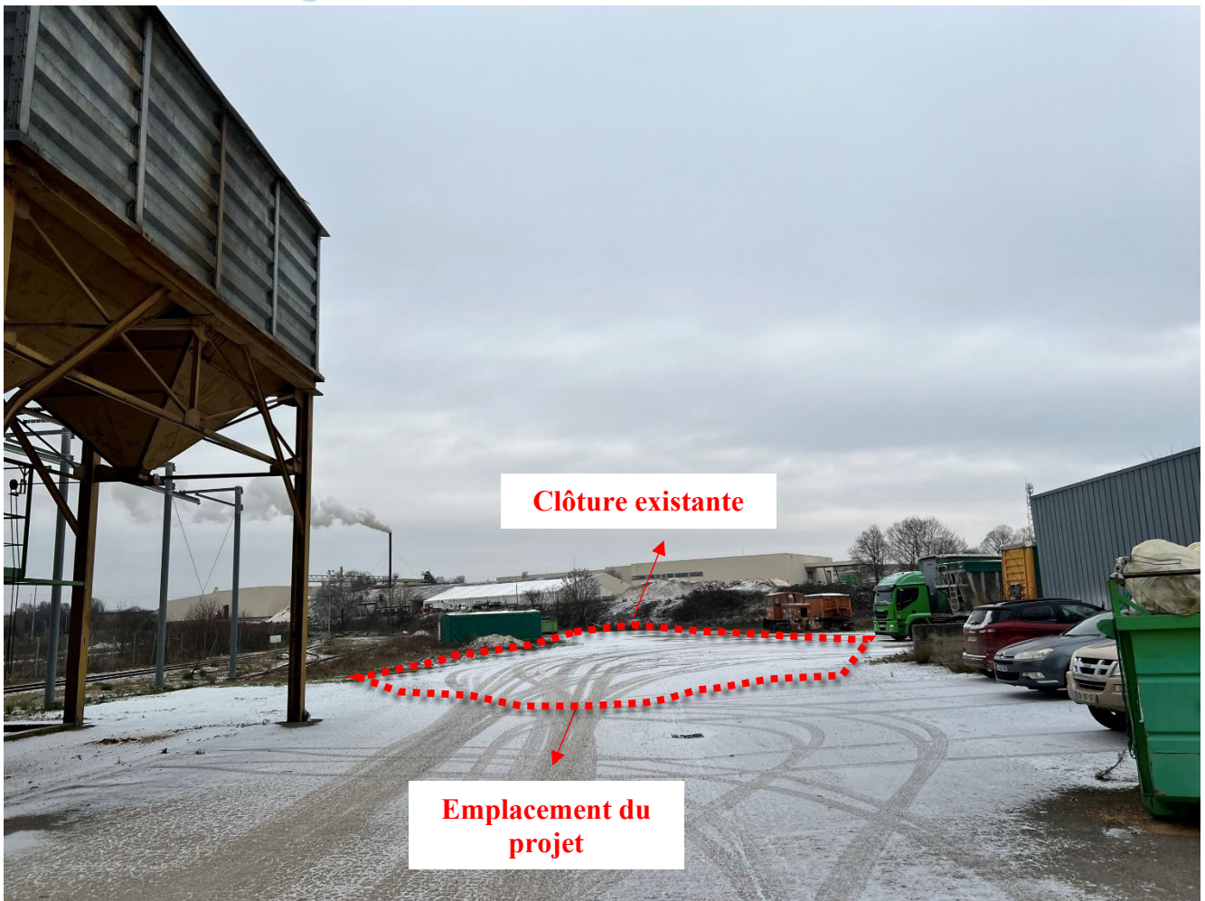
Photo 2 : Localisation de la clôture existante et emprise du projet – Site de Chatillon Sur Seine
