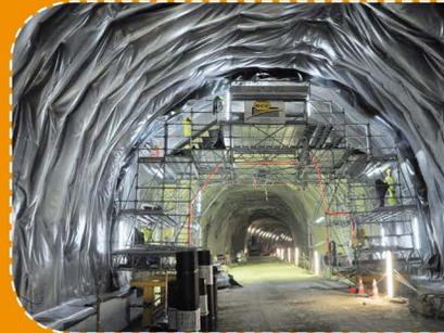
Réalisation de l'étanchéité du tunnel
