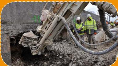
Réalisation de tirants sur le mur de soutènement
