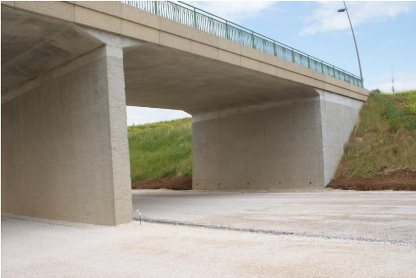
Daix - ouvrage de franchissement de la RD 107 – la couche de forme (sous l'ouvrage) est réalisée. L'enrobé définitif sera posé tout prochainement.
