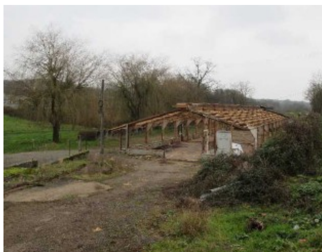
Démolition d'un bâtiment agricole à Changy
