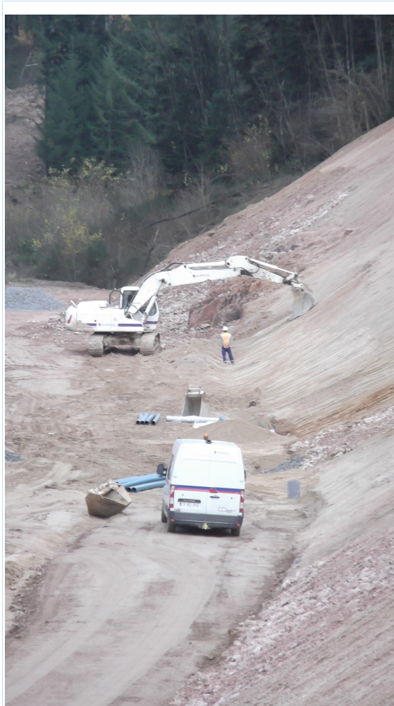
Col des Vaux - terrassements
