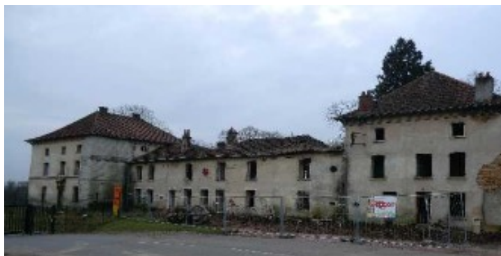
Démolition du Château d'Avoise à Montchanin
