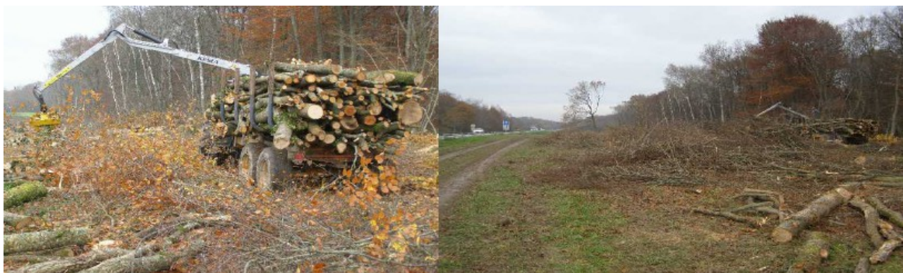
Dégagement des emprises – octobre 2014
