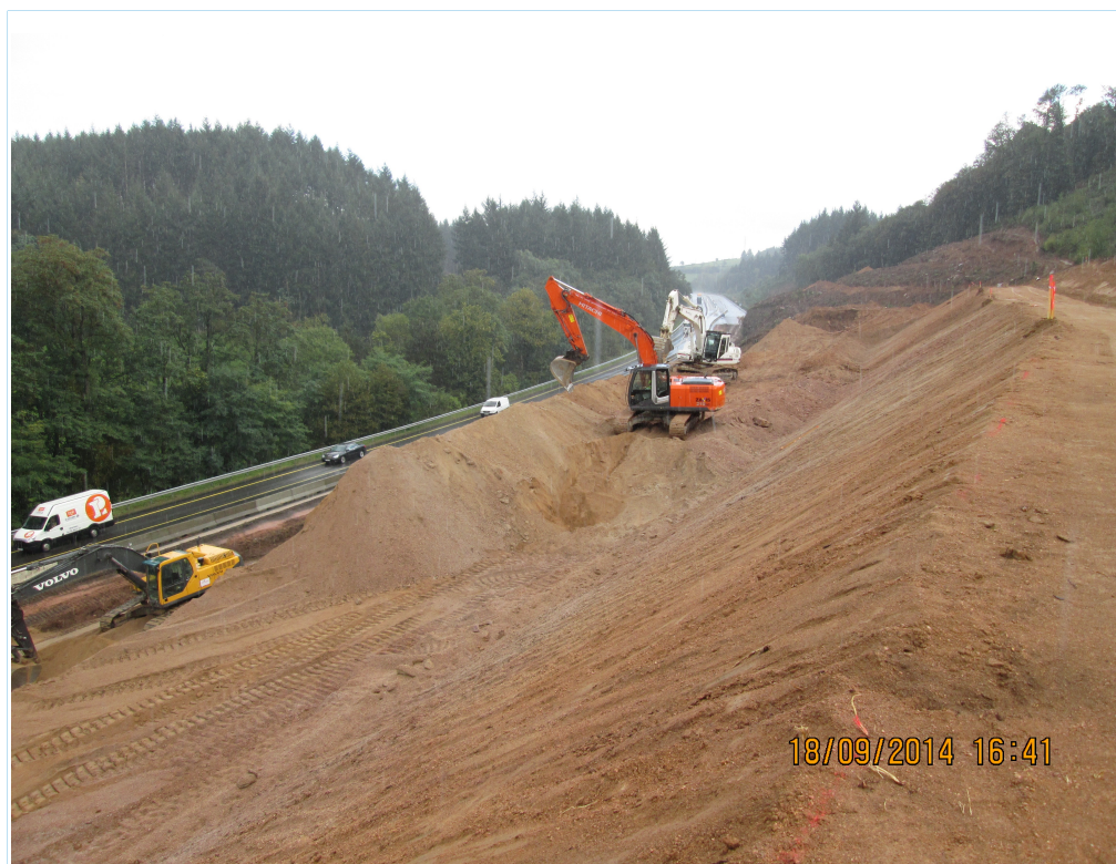
Col des Vaux - terrassements
