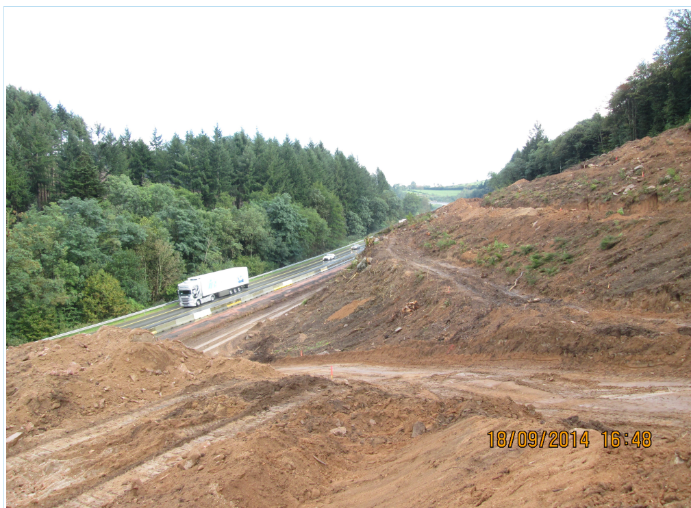
Col des Vaux - terrassements
