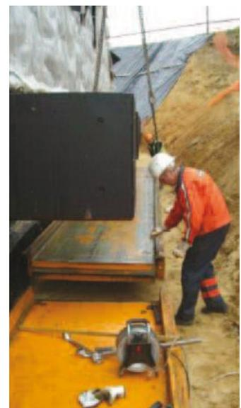
**3. Mise en place de la centrale hydraulique et branchements hydrauliques des modules**
