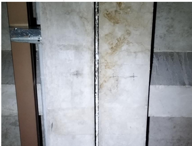
Figure 31 : Rainure sur les poutres béton
