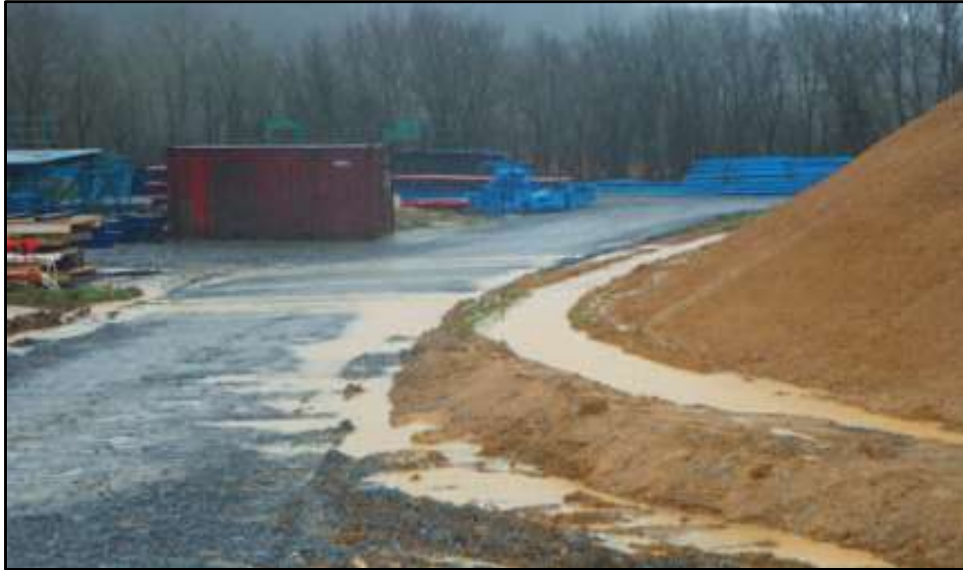
Figure 70 : Écoulements superficiels sur sols décapés non protégés contre l'érosion (Source : Photographie de Patrick Hacala, Guide Technique AFB)
