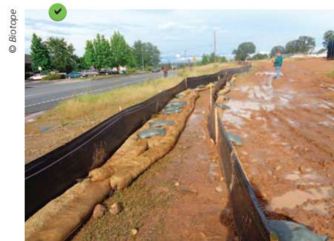
Figure 81 : Barrière de rétention pour piéger les sédiments grossiers (Source : (Source : Guide technique de l'Agence Française pour la Biodiversité (AFB) : Bonne pratique environnementale – protection des milieux aquatiques en phase chantier, 2018)
