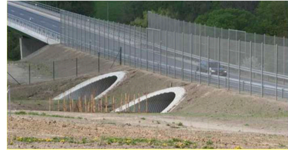
Figure 88 : Exemple allemand de clôtures de 4 mètres mises en place de part et d'autre de la voie (Source : Kathi Märki/ NACHTaktiv & WILD, CEREMA)
