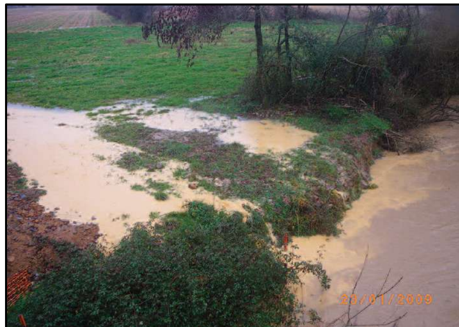
Figure 71 : Rejets de sédiments fins dans un cours d'eau en aval d'un chantier. (Source : Photographie de Patrick Hacala, Guide Technique AFB)
