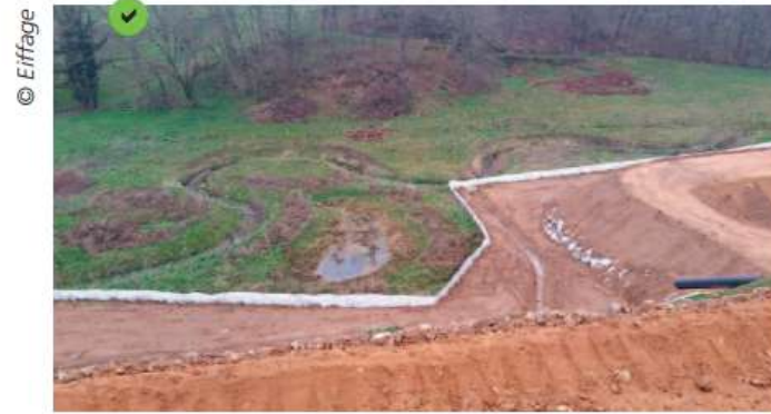
Barrière de rétention longeant un cours d'eau.
