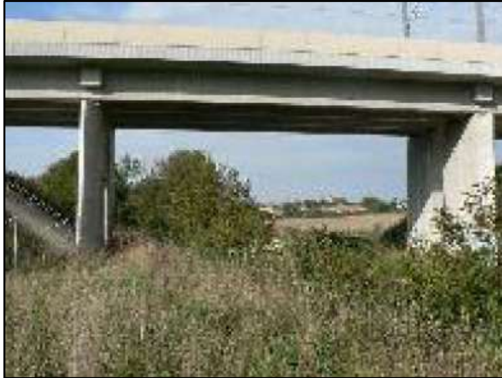
Figure 86 : LGV Est européenne – RFF/OGE/Néomys – 2010 : Viaduc de la vallée de l'Aire sous lequel la végétation a été maintenue et dont les suivis effectués de 2006 à 2010 ont permis de constater le passage d'une dizaine d'espèces de Chiroptères (Source : RFF, OGE, Néomys / CEREMA)
