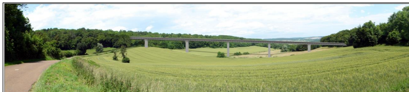
▲ Insertion visuelle facilitée par une ligne d'ouvrage sobre à hauteur constante et par une travure régulière
