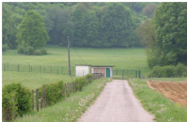
Station de pompage entre La Demie et Neurey-lès-la-Demie (captage Le Moireau utilisé par Neurey-lès-la-
