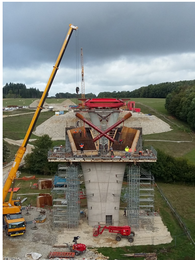
Réalisation de la pile P2
