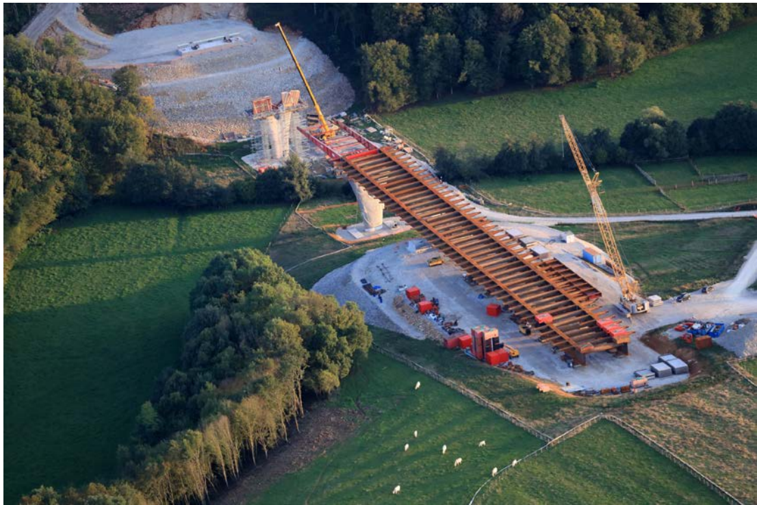
Charpente en attente du deuxième lanage
