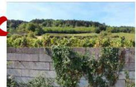
Les techniques anciennes de construction des murs de pierres sèches peuvent être reproduites par un système de construction à noyau béton avec double parement jointé avec un enduit puis brossé. Des ouvertures doivent être maintenues afin de permettre l'écoulement de l'eau et/ou de créer des cavités refuges pour la biodiversité.
