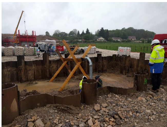
Opération de pompage dans un batardeau
