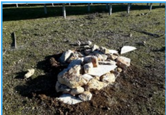
5 : Mise en place des roches.
