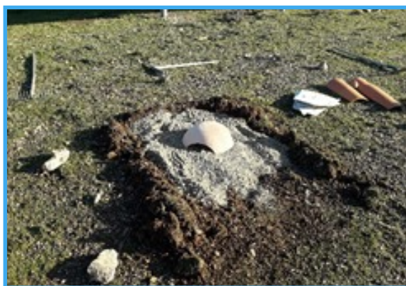
2 : Pose de sable et d'une tuile dans le creux servant d'abris hors gel. La tuile centrale utilisée ici est une rencontre 3 voies.
