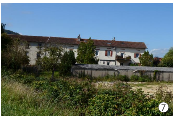
7 Un groupement de maisons mitoyennes ressemblant à un immeuble d'habitat collectif.
