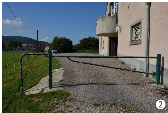
Chemin d'accès au boulodrome bloqué par une barrière constamment fermée. Les piétons passent sur la gauche.
