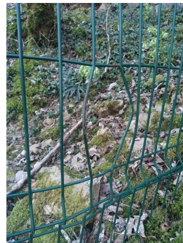
Figure 2 : Dégradation Grillage Gravelle. CPEPESC FC, 2022.
