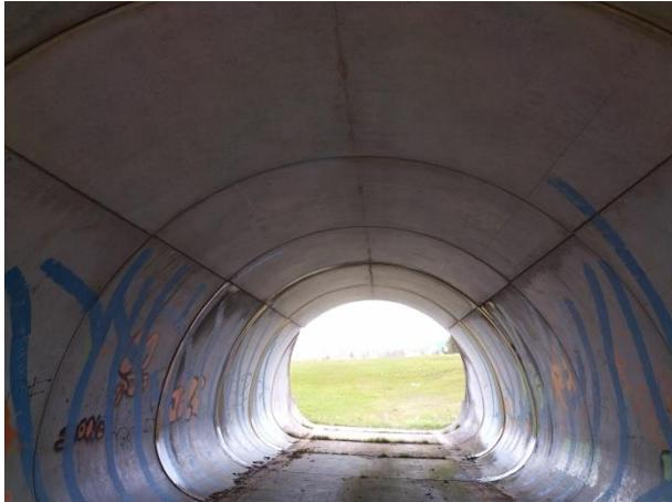
**Photographie 9 : Espaces entre les pièces en béton formant le tunnel**
