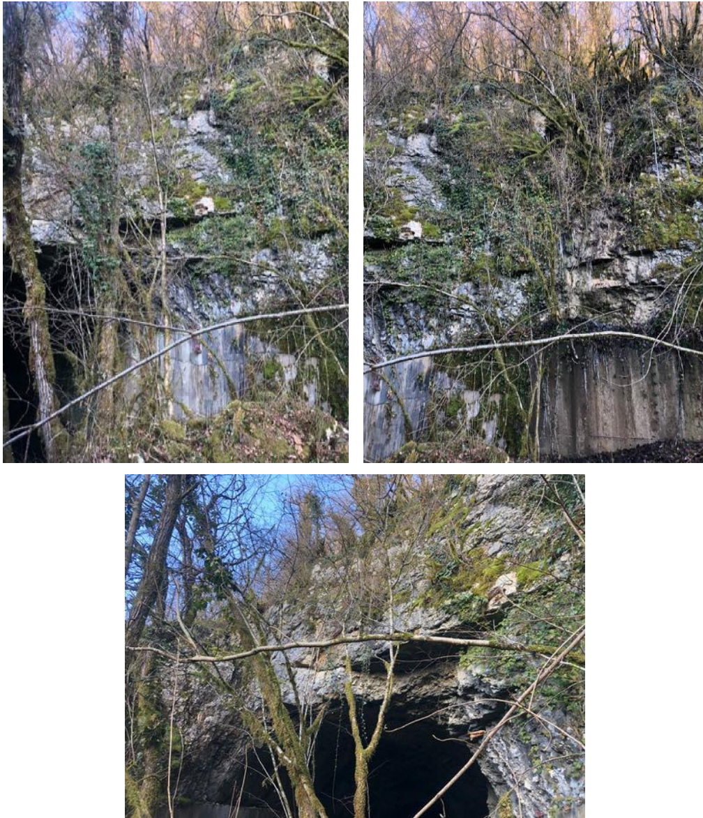
Figure 8 : Vues de la falaise en sortie de la galerie de dérivation
