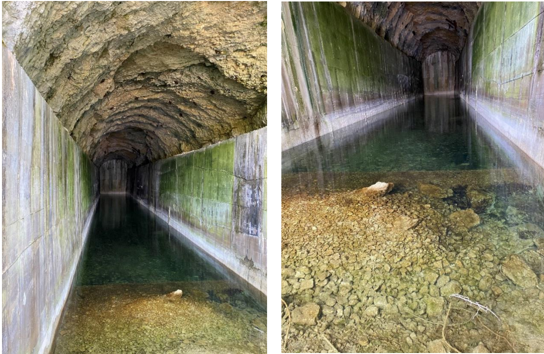
Figure 37 : Illustration de la surface en eau à compenser dans la galerie en rive gauche du barrage de Saut Mortier (©Biotec, 31/05/2023)
