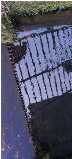
Une tour de prise d'eau équipée d'une grille fine (espacement des barreaux de 30 mm) inclinée à 76°
