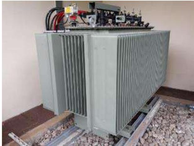
Figure 22 : Exemple de transformateur
