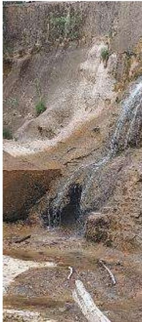
Une vanne de chasse en rive droite à gauche de la tour de prise d'eau restituant les débits de chasse au pied du barrage.
