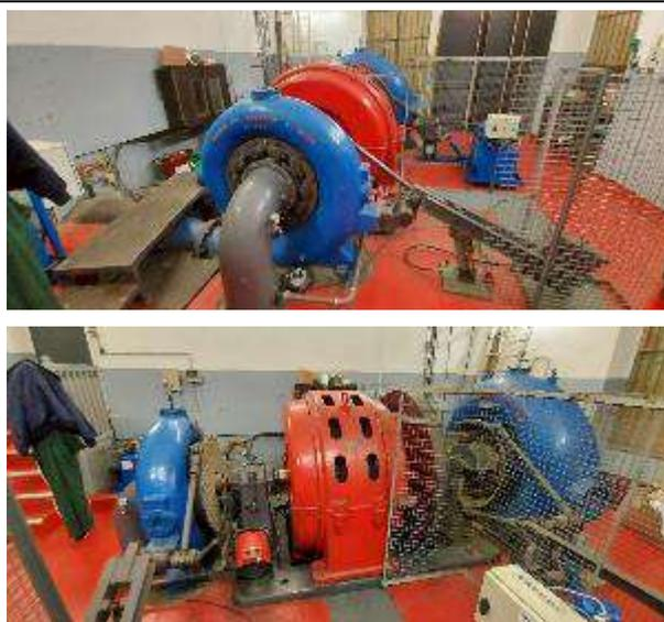
Deux turbines Francis de 333 kW (Qe 1470 l/s, Hn 34,5 m, 750 tr/min) et 90 kW (Qe 375 l/s, Hn 34,5 m, 750 /min), accouplées à un même alternateur de 476 kW.
