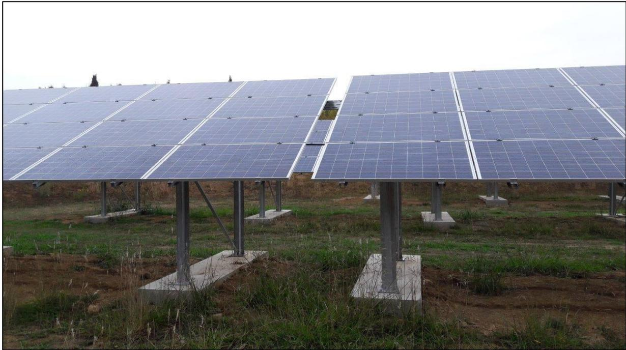
*Figure 5 : Photographie d'une table de modules sur fondation en longrines (source : Reservoir Sun)*
