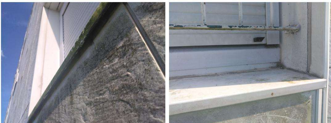
Figure 8 : Plaque d'isolant endommagée
