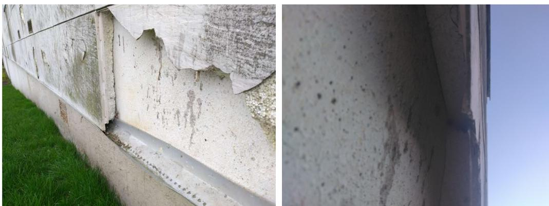
Figure 9 : Disjointements et couvertine
